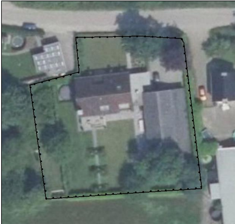
Figuur 4: Luchtfoto van het plangebied Jan Teunisstraat 12
