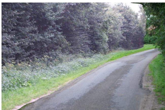
Straatzijde nieuwe situatie wegzijde Noordhoeksestraat
