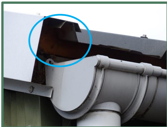
Sandwichpanelen met intacte vulling bij de goot van de loods
