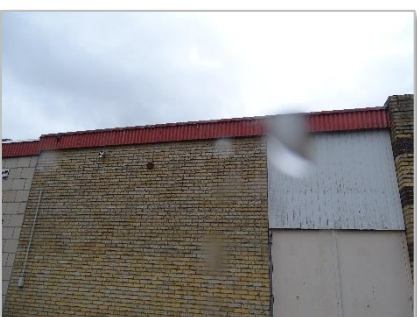
Foto 23: Geen openingen bij dakrand.
