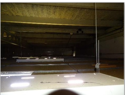
Foto 20: Impressie plangebied (plafondruimte).
