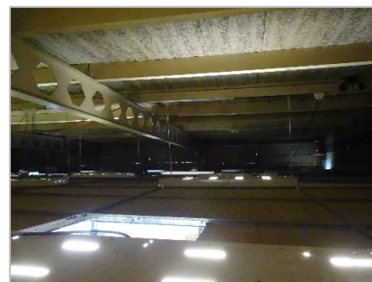
Foto 22: Impressie plangebied (plafondruimte).
