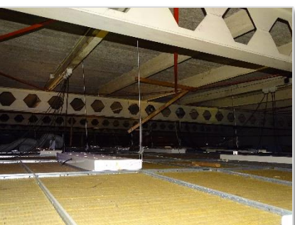
Foto 21: Impressie plangebied (plafondruimte).
