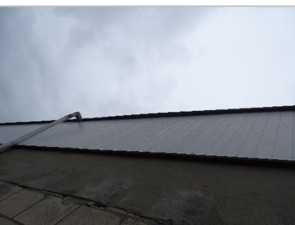
Foto 24: Geen openingen bij dakrand.
