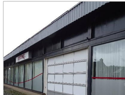
Foto 25: Geen openingen bij dakrand.
