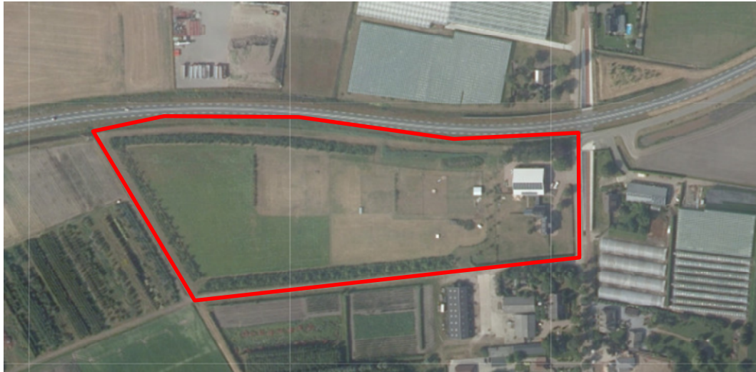
Figuur 1: Locatie op luchtfoto (noordgericht)
