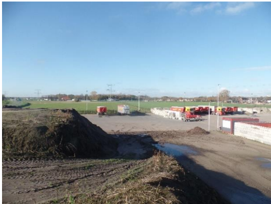
Zicht op achterliggend terrein vanaf stortberg
