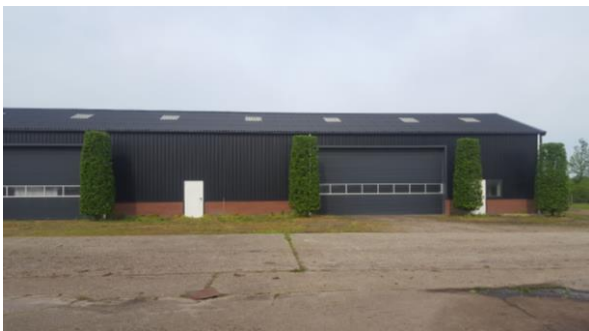
Boomkwekerijloods achterzijde Nattestraat 10 Figuur 5: Foto's planlocatie
