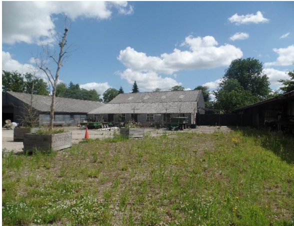
Midden de te slopen grote schuur, links veestal en geheel rechts de te slopen lage loods.
