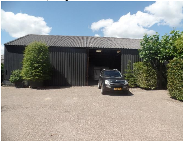
Voorkant van de te slopen schuur
