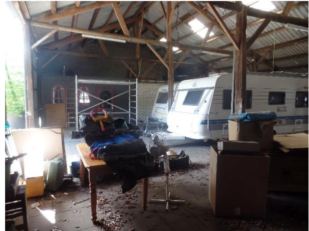
Binnenkant van de te slopen schuur.
