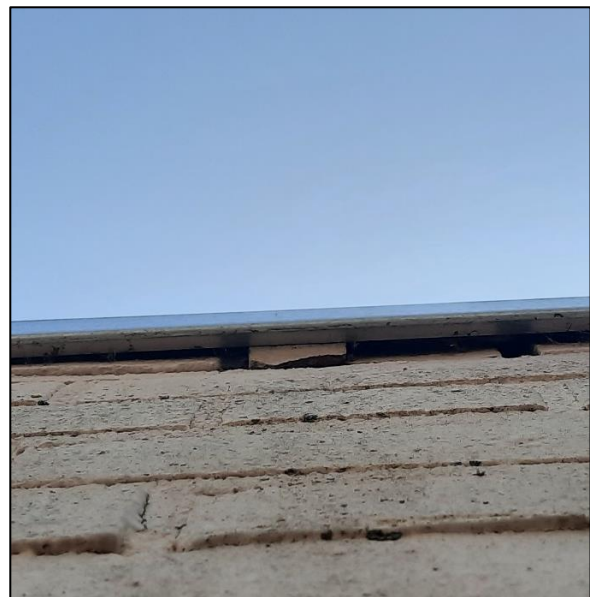
Figuur 17. Ruimte achter dakbelijsting
