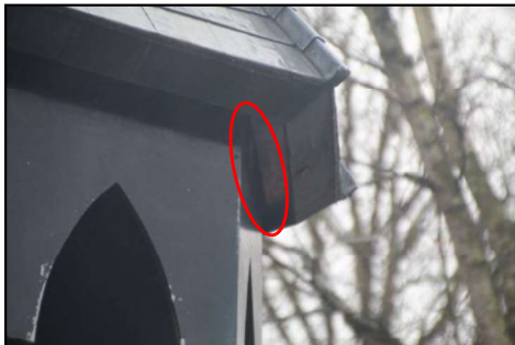
Figuur 13. Toren van een voormalig klooster, met ruimte onder het dak (aangegeven met rode cirkel).
