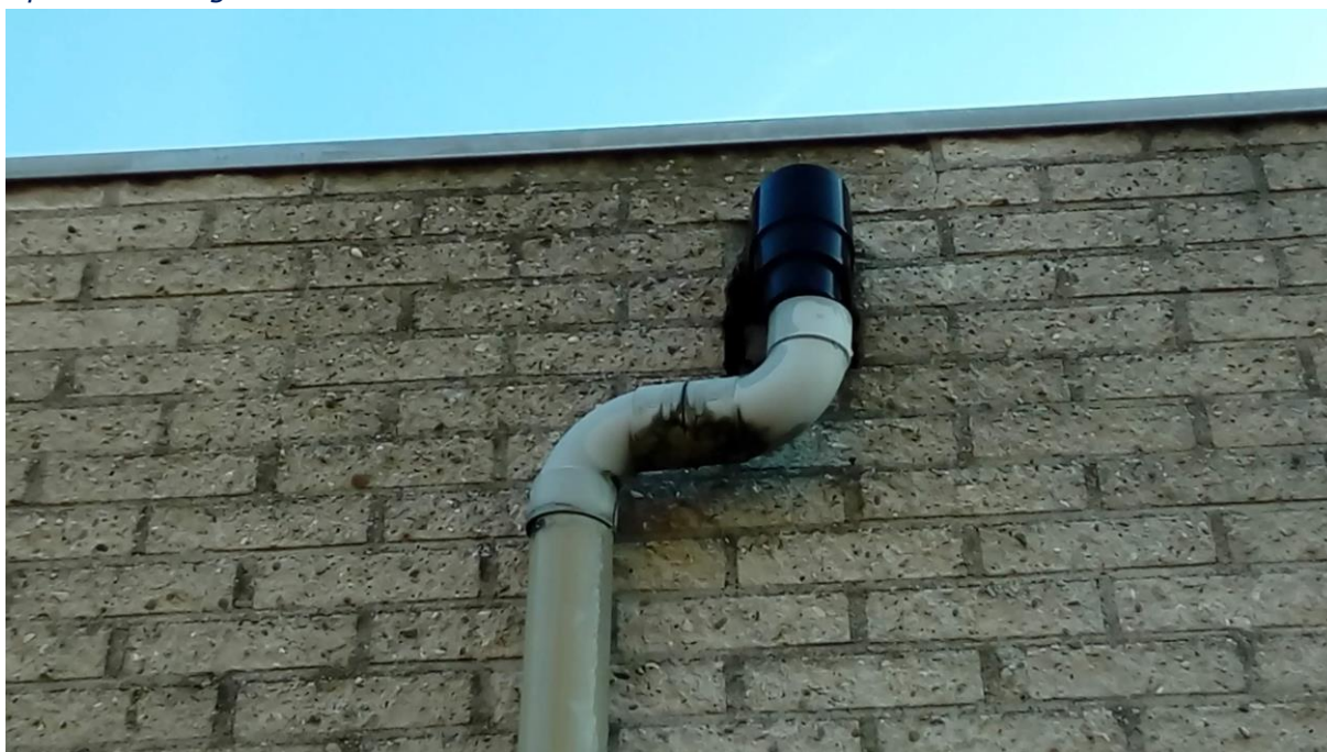
Open stuk langs de dakdoorvoer hemelwaterafvoer:
