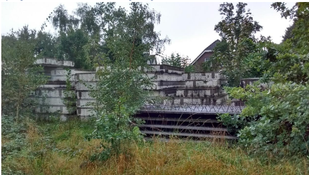
Opslag vloerdelen vanuit het westen gefotografeerd:
