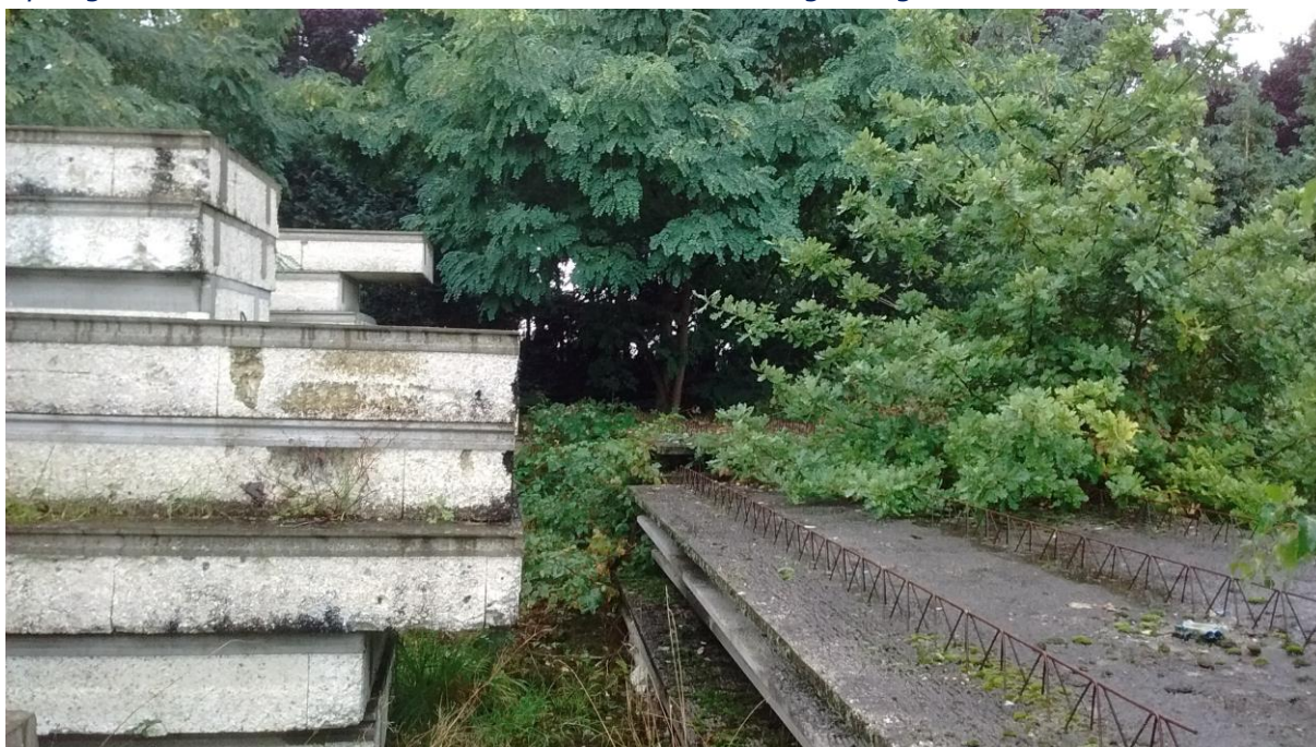
Opslag vloerdelen vanuit het noorden naar het zuiden gefotografeerd:
