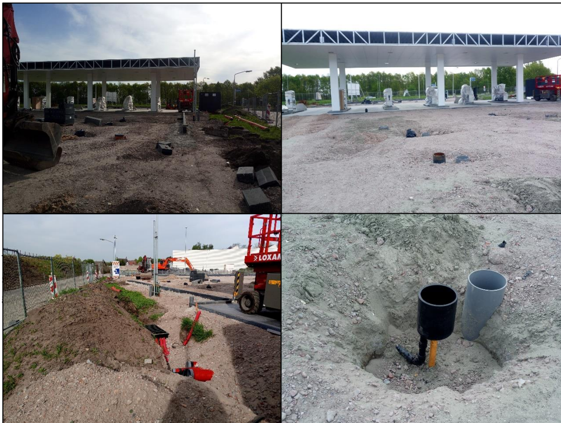
Figuur 11: Foto's van het zuidelijk deelgebied. Links- en rechtsboven: Het tankstation in aanbouw, genomen richting het oosten. Hier zijn ook de recent gegraven gaten te zien. Linksonder: een gegraven sleuf in het zuiden van het plangebied, genomen richting het westen. Rechtsonder: detail van een gegraven gat.
