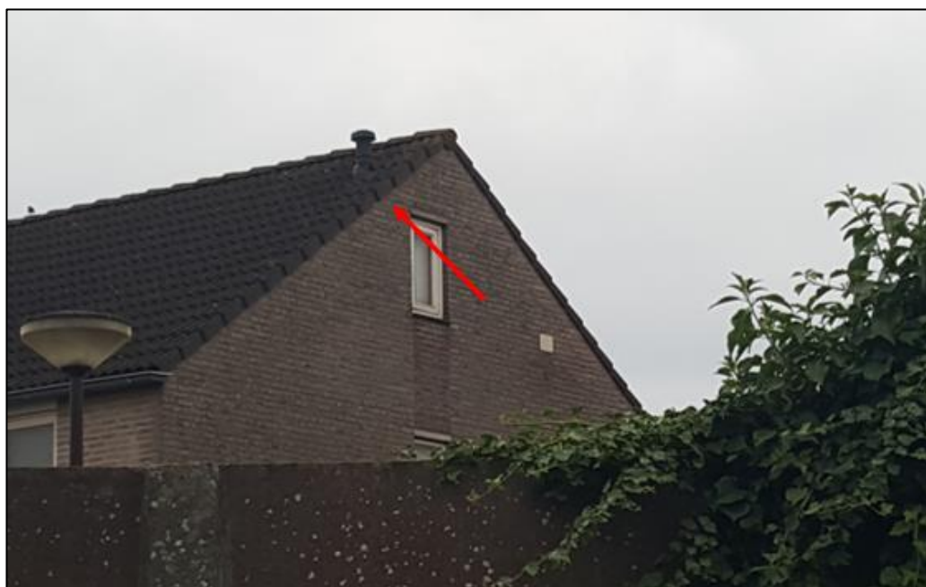
Figuur 3.2 Invliegopening onder de kantpan aan de Meidoornlaan 4.
