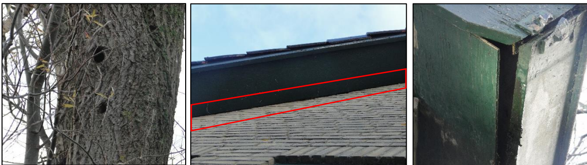
Figuur 5.5 Potentiele verblijfplaatsen voor vleermuizen in bomen (links) en gebouwen (twee rechter afbeeldingen). In de middelste afbeelding is de ruimte tussen de dakafwerking en de muren aangegeven met een rood kader.
