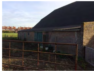
Figuur 3.2: asbestdaken Oudendijk 58
