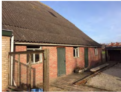
Figuur 3.1: asbestdaken Oudendijk 58
