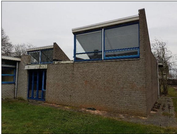
Figuur 5. Onderdeel zuidelijke deel schoolgebouw
