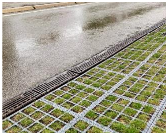
Figuur 4-8 Mogelijkheden voor de toepassing van groene parkeervakken (bron: foto gemaakt door: Ralph Stuyver, website: Groene parkeervakken: Amsterdam West – Rainproof )
