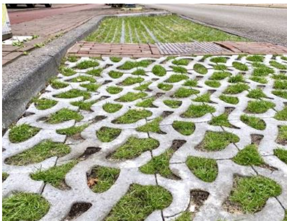
Figuur 4-8 Mogelijkheden voor de toepassing van groene parkeervakken (bron: foto gemaakt door: Ralph Stuyver, website: Groene parkeervakken: Amsterdam West – Rainproof )
