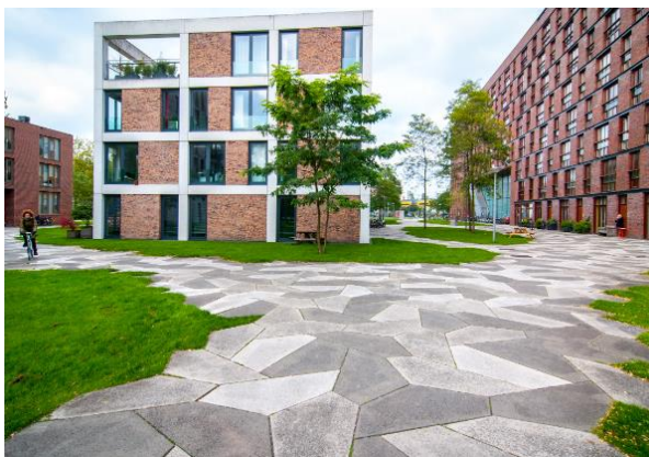
Figuur 4-6 Voorbeeld waterpasserende verharding (bron: foto gemaakt door: Merlijn Michon, website: Waterpasserende verharding – Rainproof )
