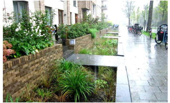
Figuur 4-5 Watervertragende groenstrook te Amsterdam (bron: Verwerken van neerslag | Waternet )
