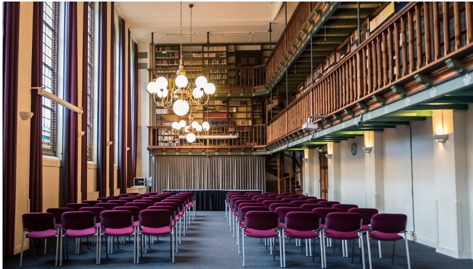
In Uythof Bovendonk bevindt zich een grote galerijbibliotheek met gemetselde troggewelven en twee houten galerijen opgehangen aan smeedijzeren stangen. De bibliotheek wordt verlicht door hoge tweedelige korfboogramen.
