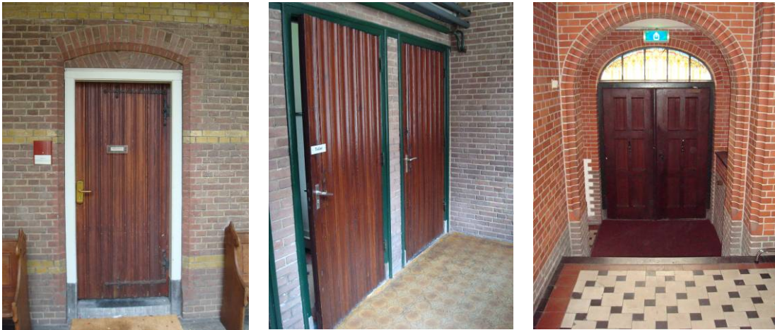
Afb. 142, afb. 143 en afb. 144 (v.l.n.r.): verschillende buitendeuren met opgelegde verticale delen: deur naar een klaslokaal onder de hofarcade, toiletdeuren in de noordelijke toilet-uitbouw en binnenzijde van een buitendeur in de zuidvleugel met zichtbare stijlen en dorpels.
