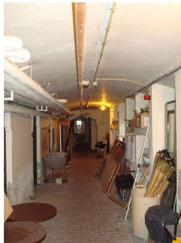
Afb. 122 Gedrukt ton- of segmentgewelf in de keldergang onder de voorbouw.
