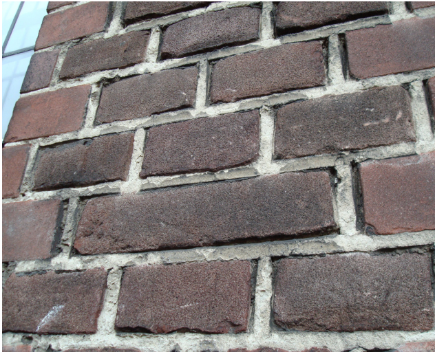
Afb. 259 en afb. 260 Beschadigd voegwerk aan de rechter voorgevelrisaliet (links) en aan de noordelijke gevel van de binnenhof (rechts). Herstel van de oorspronkelijke snijvoeg, waarbij de oorspronkelijke mortelreceptuur wordt gebruikt, staat hoog op de agenda.
