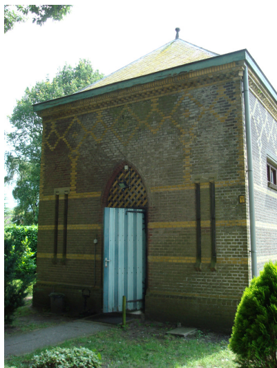
Afb. 187 Voorzijde (noordzijde) van het 'kamelenkot'.
