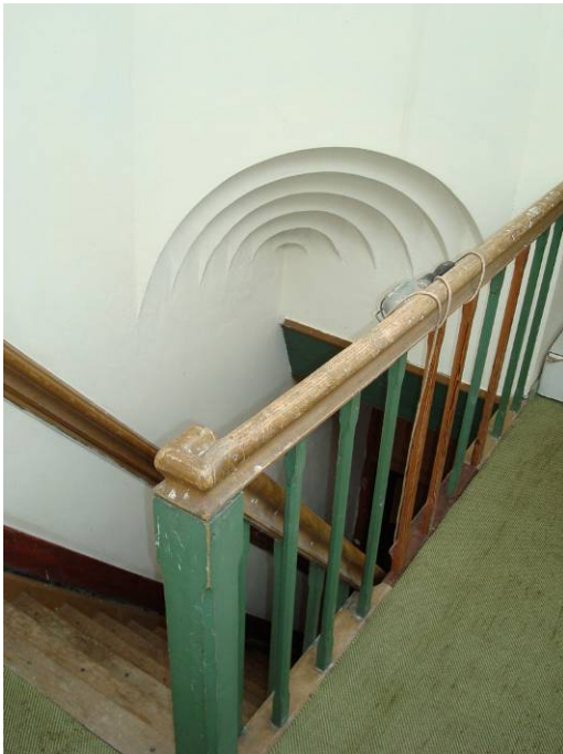
Afb. 80 Tromp ter hoogte van de insnoering van de noordelijke traptoren, op de derde verdieping.
