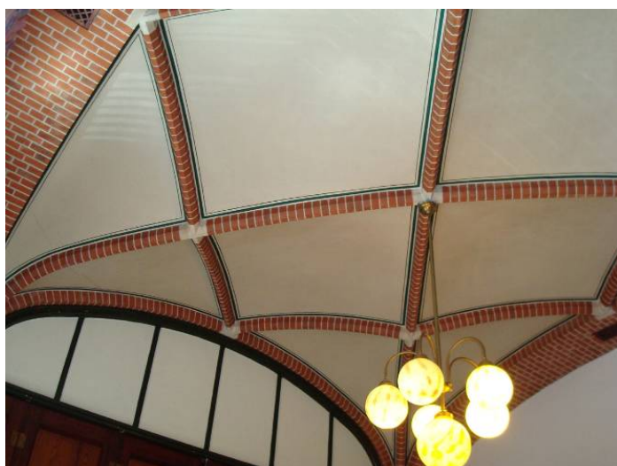
Afb. 106 Een van de netgewelven in de vergaderzalen naast de vestibule.
