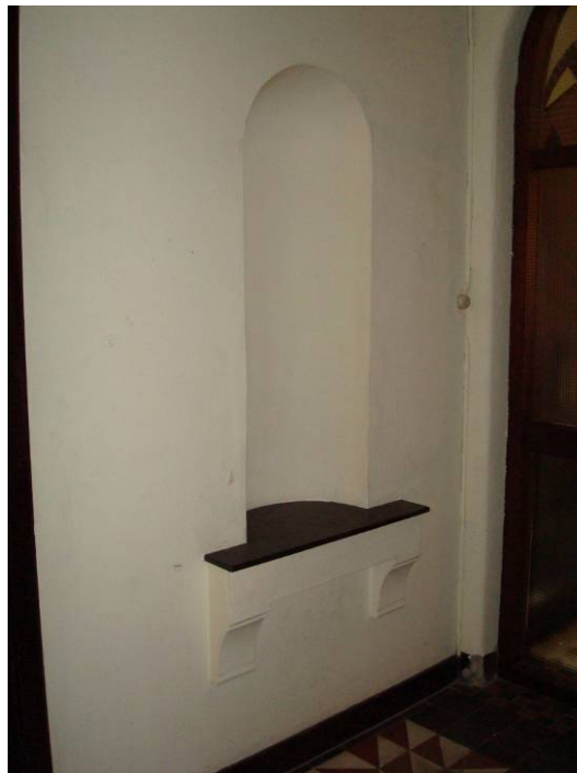
Afb. 100 Lege beeldnis in de gang op de eerste verdieping van de zuidvleugel (oostzijde), naast de nieuwe tochtput bij de aansluiting op het trappenhuis. Langs de vloer een zwartgeschilderde houten plint.
