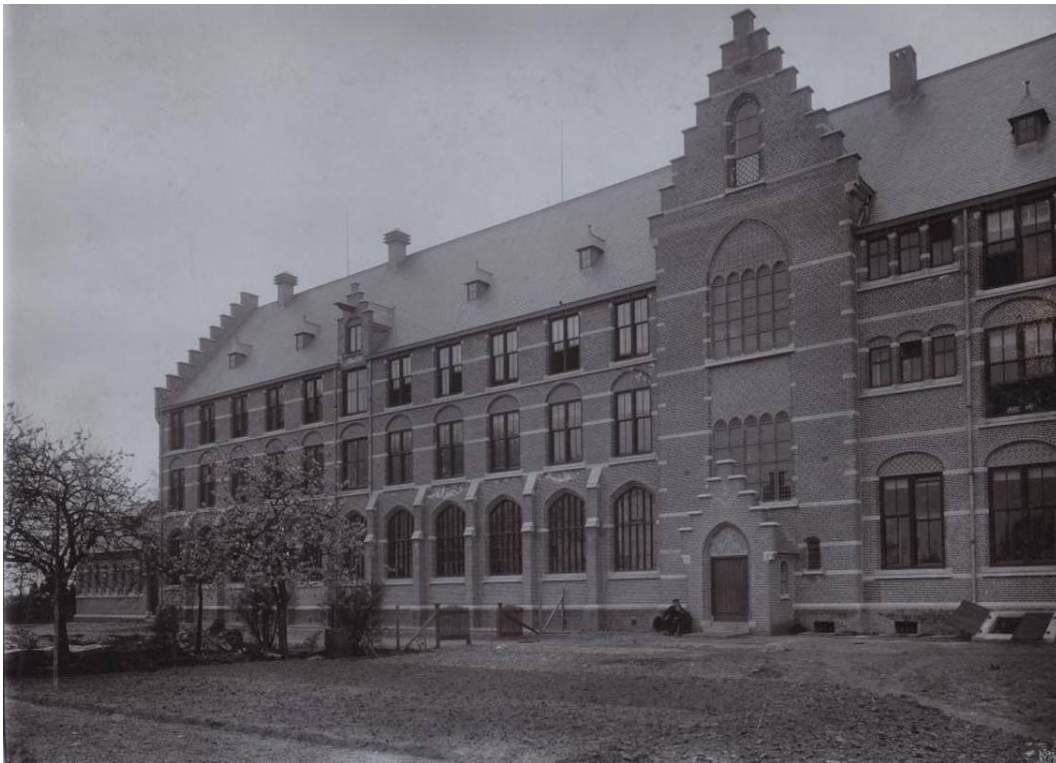
Afb. 15 Westelijke helft van de zuidgevel op een historische foto. Achter de risaliet met trapgevel en uitgebouwd portaal bevindt zich het trappenhuis. De oorspronkelijke donkere afwerkklagen van de vensters en deuren zijn goed zichtbaar (NAi).
