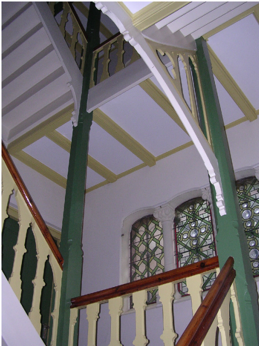
Afb. 224 Trappenhal van de pastorie in Ouderkerk: de inspiratie van Pugins hammerbeam-kappen is hier vertaald in hout.
