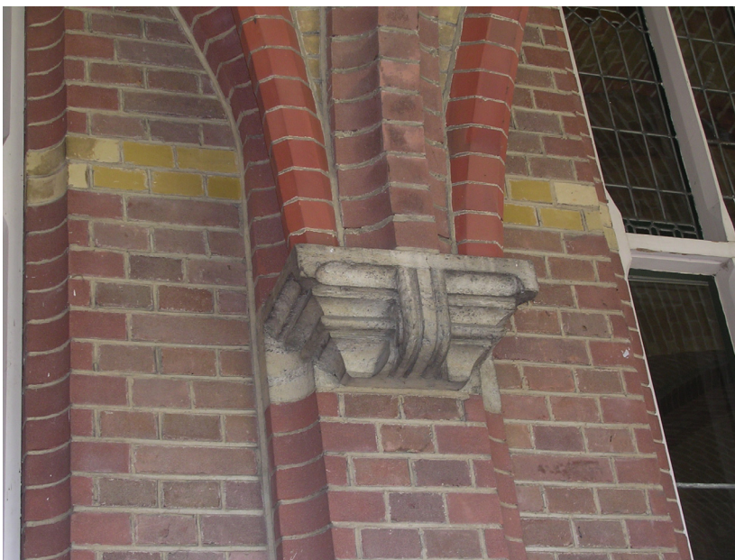
Afb. 262 Een van de consoles in de galerij aan de hof is vormgegeven als een stenen 'vergrendeling' van de centrale gewelfrib daarboven.
