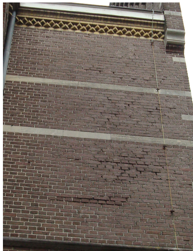
Afb. 259 en afb. 260 Beschadigd voegwerk aan de rechter voorgevelrisaliet (links) en aan de noordelijke gevel van de binnenhof (rechts). Herstel van de oorspronkelijke snijvoeg, waarbij de oorspronkelijke mortelreceptuur wordt gebruikt, staat hoog op de agenda.
