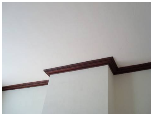
Afb. 134 Vlak stucplafond met houten kooflijst in een van de zitkamers van de professoren.
