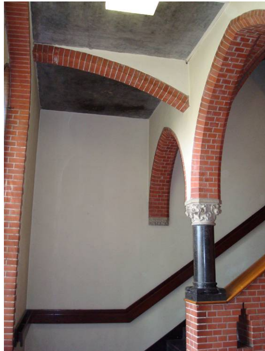
Afb. 68 Detailopname van het trappenhuis in de zuidvleugel, gezien vanaf het bordes tussen de begane grond en de eerste verdieping.
