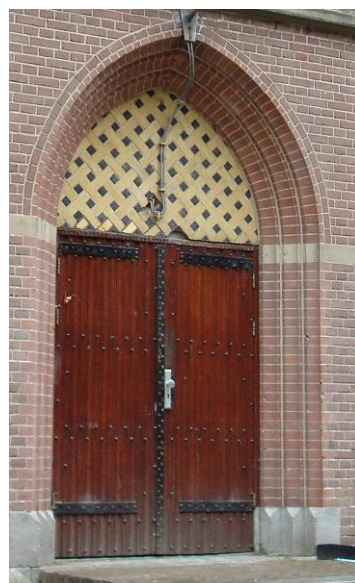
Afb. 141 Dubbele deur in het hoofdportaal in de noordgevel.
