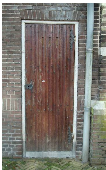
Afb. 140 Keldertoegang in de zuidgevel.
