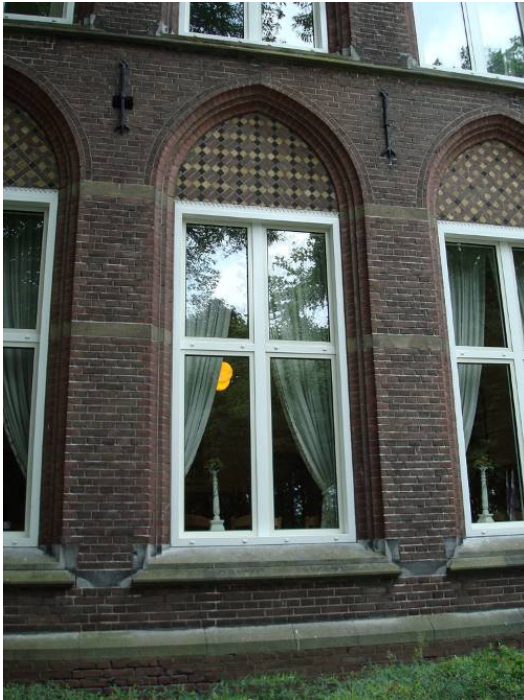
Afb. 28 Metselmozaïek in de boogtrommel van een venster in de voorgevel.
