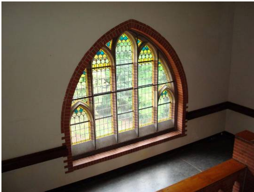
Afb. 74 Klimmende lancetvensters in een spitsboogvormige raamopening op het derde bordes van de noordvleugel.
