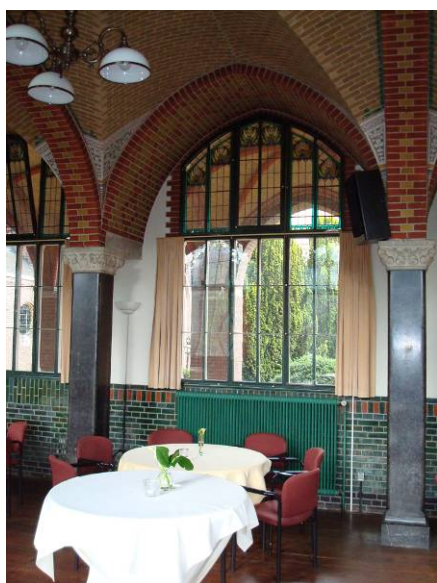
Afb. 101 Gedeelte van de wand in de recreatiezaal met lambris van geglaazuurde bakstenen.
