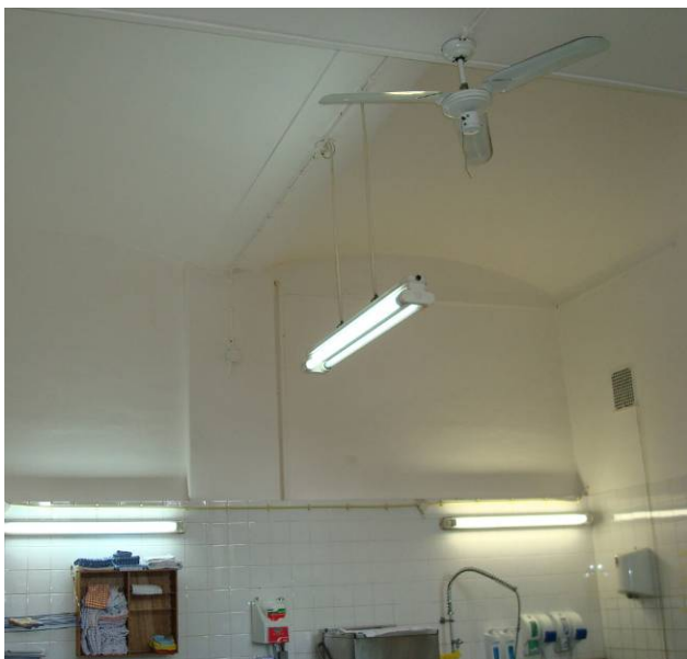
Afb. 125 Pruisische kap in de keuken met brede, lage troggewelven op drievoudig gekoppelde ijzeren I-profielen.
