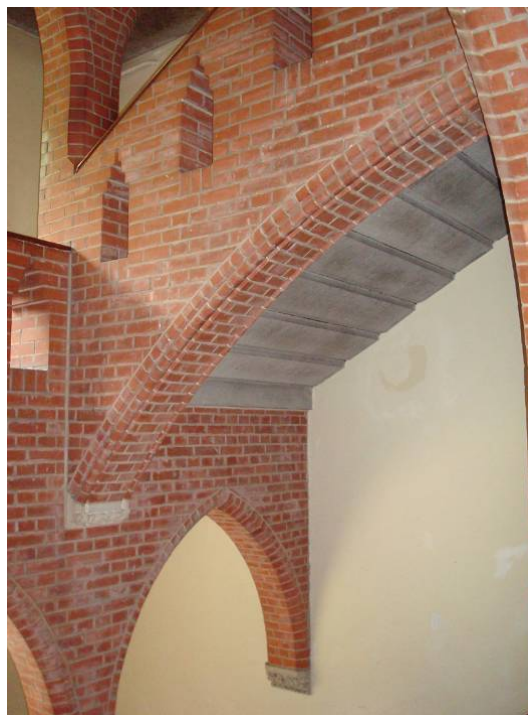
Afb. 64 Onderzijde van de derde vlucht van de trap in de noordvleugel.
