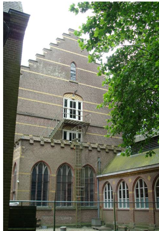
Afb. 31 Speklagen van gele bakstenen in de westgevel van de zuidvleugel.
