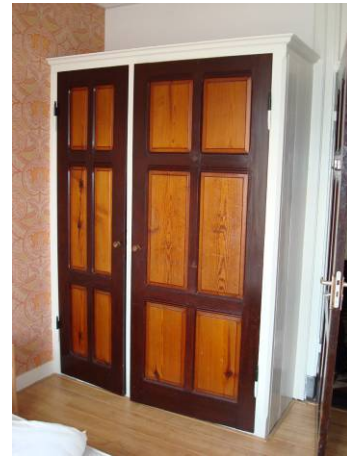
Afb. 145, afb. 146 en afb. 147 (v.l.n.r.): voorbeelden van deuren op verschillende plaatsen in Bovendonk: kamerdeur in de zuidvleugel, deur naar de sacristie in de hoofdvleugel en dubbele kast met smalle en brede deur in een kamer in de noordvleugel. De oorspronkelijke polychromie is nog intact: donkergroen kozijn met donkergebeitste belegstukken; de panelen van de deuren en het bovenlicht zijn lichtgebeitst, de stijlen en dorpels donker.
