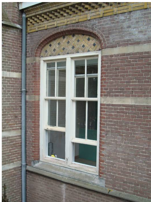
Afb. 166 Gekoppeld schuifvenster met roedeverdeling op de tweede verdieping van de noordvleugel (buitengevel).
