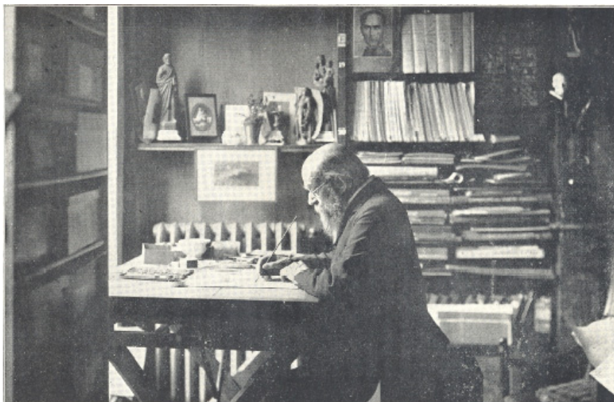
Afb. 229: Cuypers in zijn werkkamer in Roermond met op de achtergrond een grote verwarmingsradiator.
