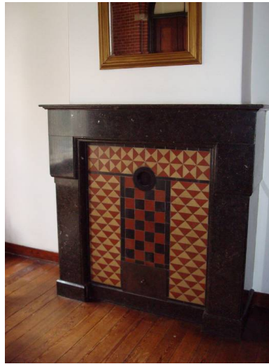
Afb. 168 Links: ontwerptekening voor een van de twee schouwen in de 'grote zaal', de reeks van drie geschakelde vergaderzalen in de hoofd-vleugel. Afb. 169 Rechts; schouw van hardsteen met tegels in decoratieve patronen in de meest zuidelijke van de drie vergaderzalen.
