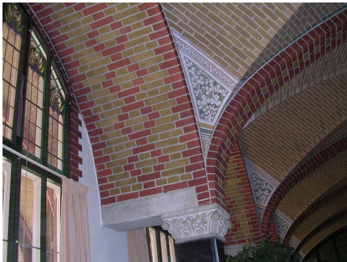
Afb. 113 Het repeterende effect van de gewelfaanzetten krijgt een bijzonder effect door de geschilderde accentuering van de graten, waar als het ware een naar buiten geplooiide zwik ontstaat.
