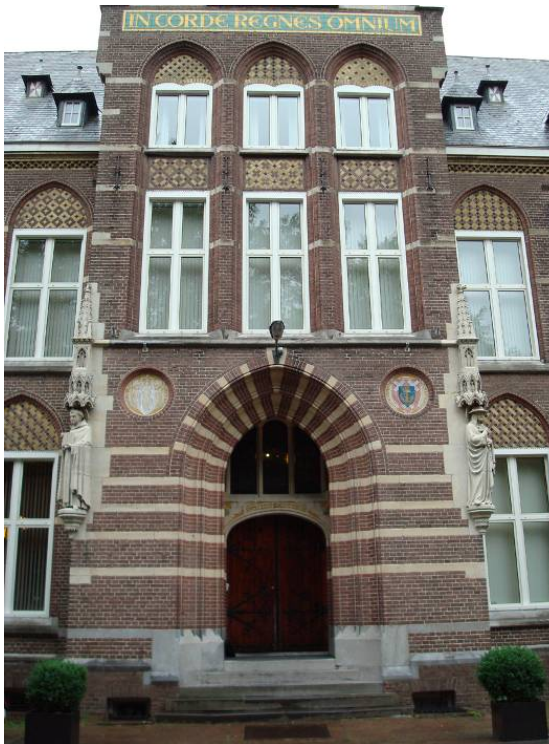
Afb. 30 Speklagen van natuursteen in de middenrisaliet van de voorgevel.
