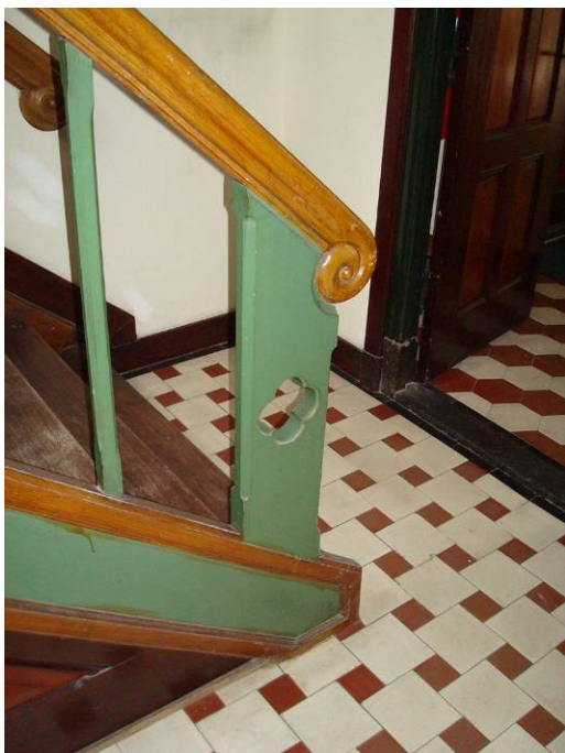
Afb. 76 Beginbaluster met open vierpas en gebosserde trapspijl in de noordelijke traptoren.
