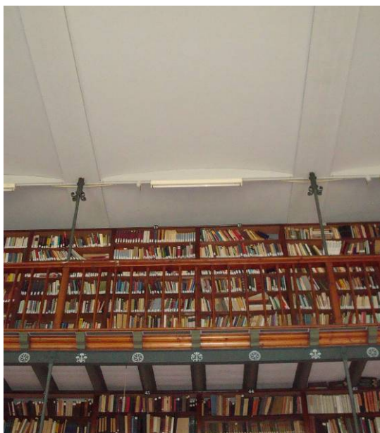
Afb. 123 Detailopname van de galerij en de overwelfingsconstructie in de bibliotheek. De stangen waarmee de galerijen aan de ijzeren I-profielen hangen zijn duidelijk zichtbaar.
