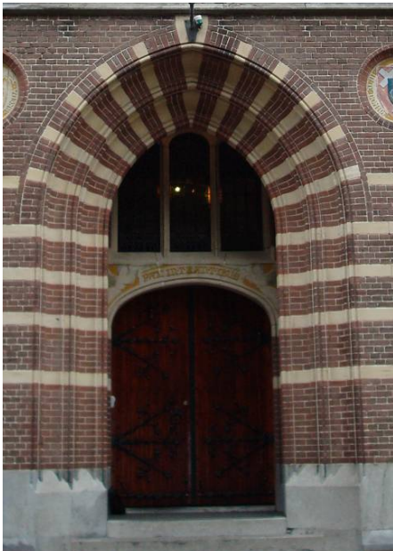
Afb. 35 Profielstenen in het hoofdportaal in de voorgevel.
