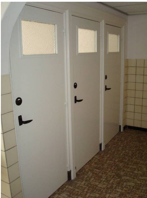
Afb. 160 Wc-deuren op de eerste verdieping van de zuidvleugel.
