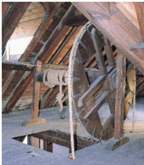
Afb. 193 Links: hijssrad op de zolder van de zuidvleugel. Afb. 194 Rechts: hijssrad uit de zeventiende- of achttiende eeuw in het woonhuis Herengracht 502 in Amsterdam.
