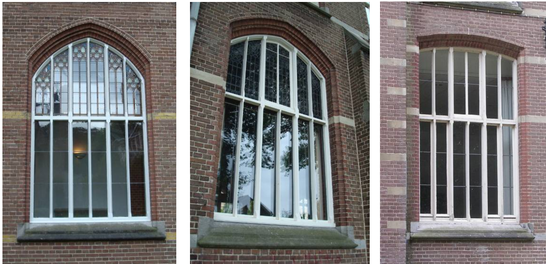
Afb. 163, afb. 164 en afb. 165 (v.l.n.r.): venster van de gang (hofzijde), refter (buitenzijde) en klaslokaal (buitenzijde). De indeling van de vensters is grotendeels gelijk, slechts de beëindiging aan de bovenzijde verschilt.
