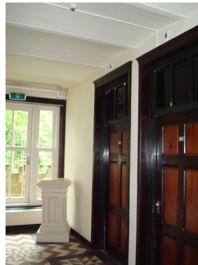
Afb. 118 Pruisische kappen in een van de gangen in de zuidvleugel van Bovendonk.
