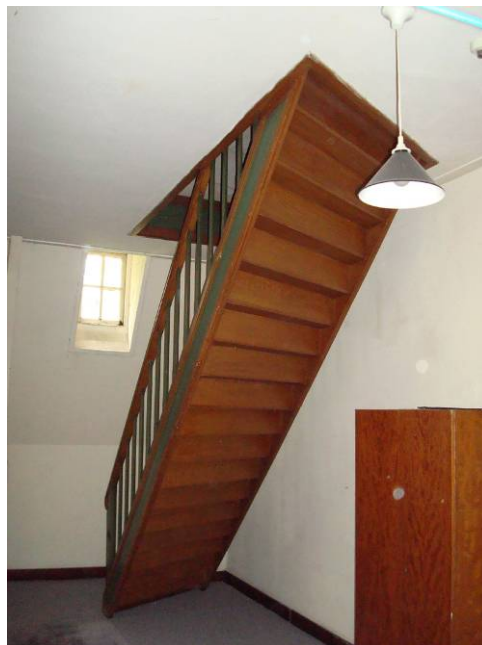
Afb. 83 De scheluwe steektrap naar de zolder van de zuidvleugel.
