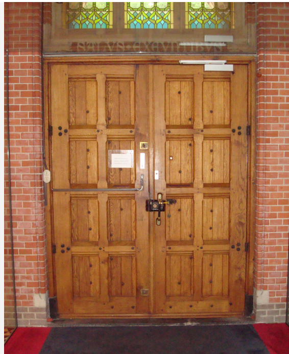
Afb. 138 Binnenzijde van het hoofdportaal met zichtbaar stijl- en regelwerk.
