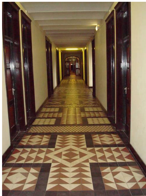
Afb. 130 Middengang in de zuidvleugel, tweede fase (1904-1905), met gemetselde troggewelven op ijzeren I-profielen.
