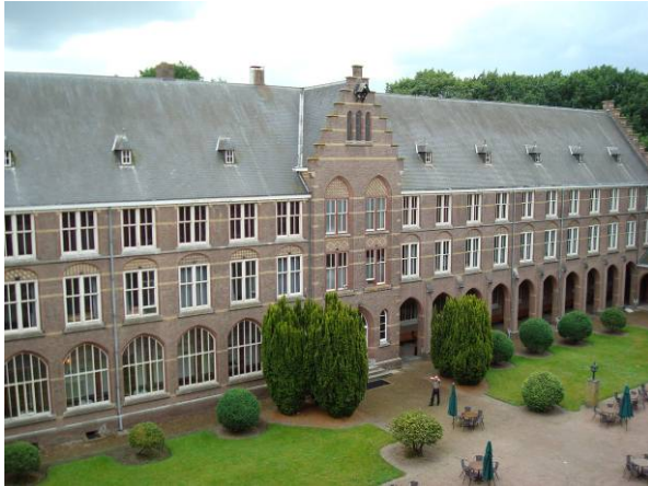
Afb. 21 Overzicht van de zuidelijke hofgevel.
