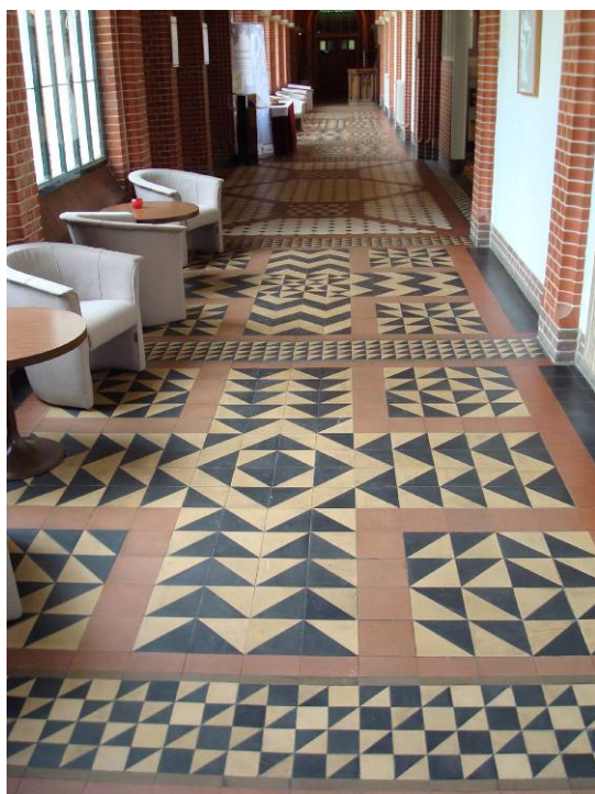
Afb. 84 Tegelvloer op de begane grond van de hoofdvleugel, gezien naar de vestibule.
