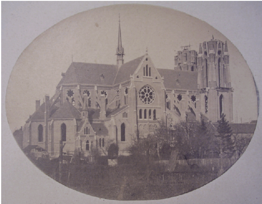
Afb. 237 De (hier nog onvoltooide) Catharinakerk te Eindhoven circa 1862, is het eerste gebouw waarbij Cuypers samen met Thijm de ideeën uit De Heilige Linie integraal verwerkte. Hij wist dit programma te realiseren binnen de beginselen van het ‘redengevende’ bouwen dat toen nog in de kinderschoenen stond. Het gebouw is een constructief waagstuk in baksteenpolychromie.
