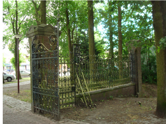
Afb. 190 Binnenzijde van het linkergedeelte van het toegangshek.
