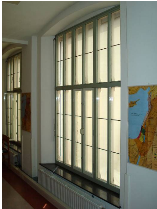
Afb. 128 Detailopname van de 'nieuwe bibliotheek', met pilaster tussen twee vensters, opgelegde balk en vlak gewelf. De vensters volgen de vorm van het gewelf.
