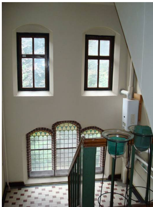
Afb. 77 Zicht op de vensters van de noordelijke traptoren, vanaf het bordes van de tweede verdieping.
