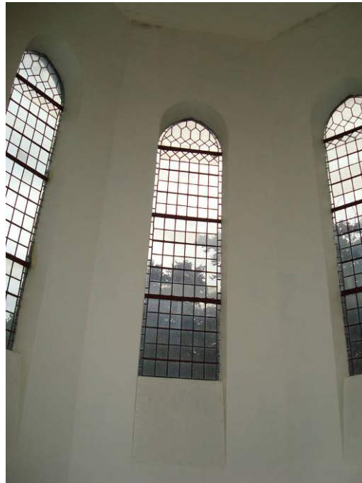
Afb. 81 Blick in de noordelijke traptoren. De smalle hoge lancetvensters hebben vullingen van blank glas-in-lood.
