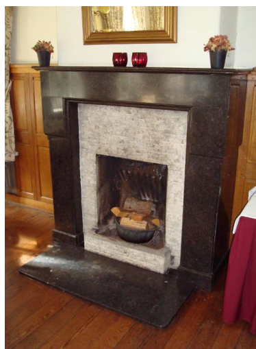
Afb. 170 L: ontwerptekening voor de schouw in de voormalige eetzaal van de professoren. In de hoeken van de achterwand zijn draakjes uitgebeeld. Afb. 171 R: schouw in de voormalige eetzaal van de professoren. De stookopening is vergroot en rondom afgewerkt met ruw behakte grijze marmers strips.
