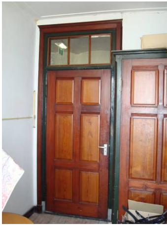
Afb. 145, afb. 146 en afb. 147 (v.l.n.r.): voorbeelden van deuren op verschillende plaatsen in Bovendonk: kamerdeur in de zuidvleugel, deur naar de sacristie in de hoofdvleugel en dubbele kast met smalle en brede deur in een kamer in de noordvleugel. De oorspronkelijke polychromie is nog intact: donkergroen kozijn met donkergebeitste belegstukken; de panelen van de deuren en het bovenlicht zijn lichtgebeitst, de stijlen en dorpels donker.
