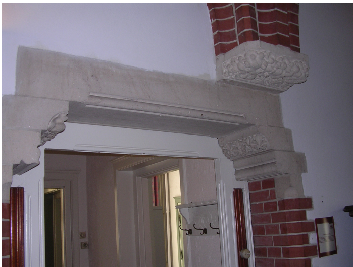
Afb. 108 Kraagsteen en gewelfaanzet boven een deuropening in de gang op de begane grond.
