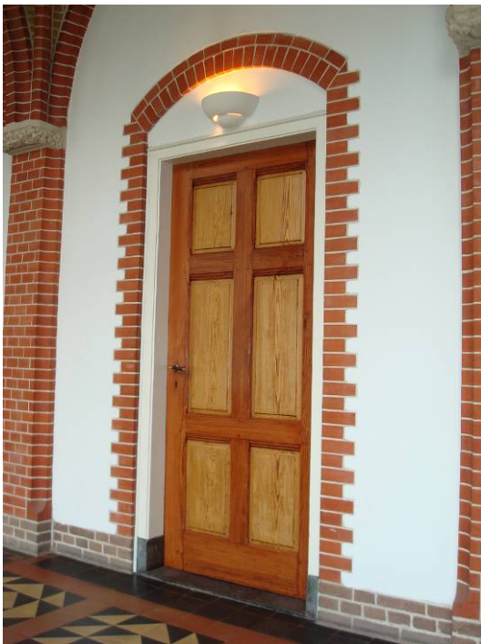
Afb. 99 Deur in de gang op de begane grond van de hoofdvleugel. Rondom de deuropening is een decoratieve rand van rode verblendstenen aangebracht. De plint is van schoon metselwerk in bruinrode bakstenen.
