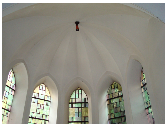
Afb. 115 Polygonaal graatgewelf boven het koor van de dagkapel of Zusterkapel.
