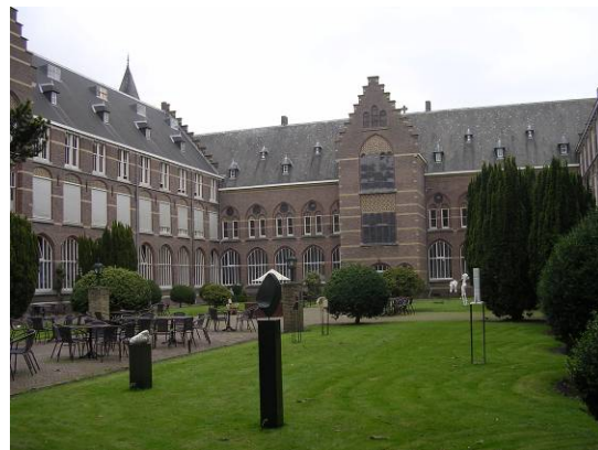
Afb. 24 De oostelijke hofgevel.
