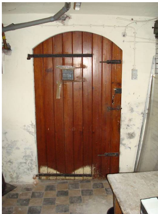
Afb. 162 Delendeur tussen de bakkerij en de vroegere kolenberging in de zuidvleugel. De ijzeren gehengen en duimen zijn zichtbaar.
