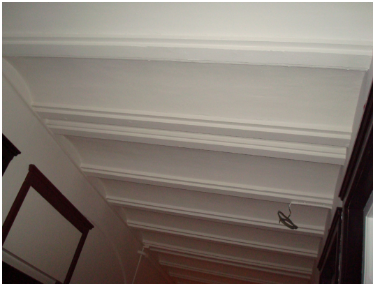
Afb. 131 Westelijke middengang op de tweede verdieping van de noordvleugel. Houten balken dragen hier de gemetselde troggewelfjes.
