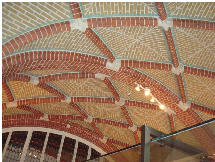
Afb. 104 Het netgewelf in de vestibule.
