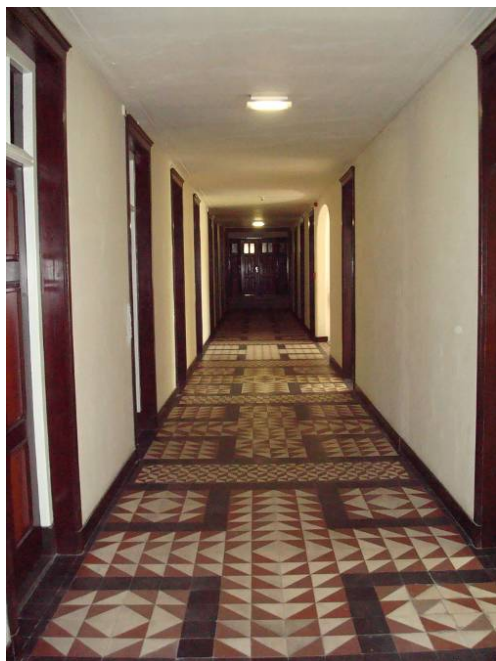
Afb. 129 Middengang in de zuidvleugel, eerste fase (1903-1904), met stucplafonds onder houten balklagen.
