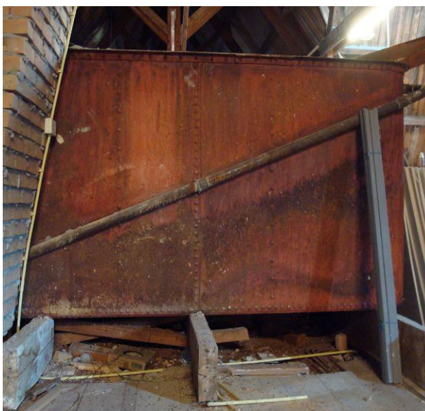
Afb. 184 Een van de twee open kuipen van geklonken ijzer op de zolder van de zuidvleugel die deel uitmaakte van het grijswatercircuit.
