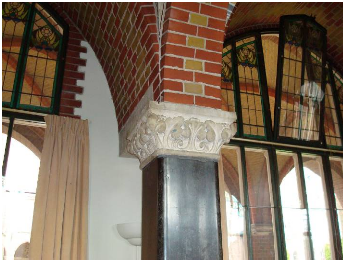
Afb. 111 Detailopname van een kolom met kapiteel en gewelfaanzet in de recreatiezaal/refter.
