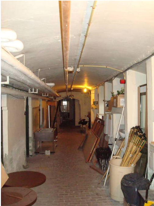
Afb. 95 Klinkervloer in de keldergang onder de voorbouw. Alle vloeren zijn in dit bouwdeel met klinkers belegd.
