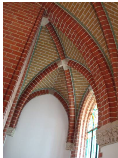
Afb. 105 Klimmend kruisgewelf naast het ingangsportaal.
