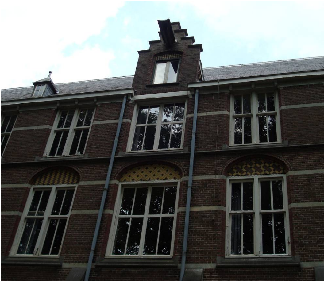
Afb. 16 Detailopname van de westelijke helft van de zuidgevel met twee venstervormen. In de middenrisaliet de brede stolpramen waarachter zich de dwarsgangen bevinden. Ter weerszijden van de middenrisaliet de gekoppelde smalle schuifvensters van de studentenkamers.
