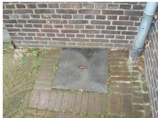
Afb. 185 L: de regenbak op de binnenhof, op een uitsnede van een ongedateerde situatietekening (NAi). Afb. 186 R: een van de putten voor de opvang van hemelwater, naast de hoofdingang. Via ondergrondse buizen werd het water naar de regenbak op de binnenhof geleid.
