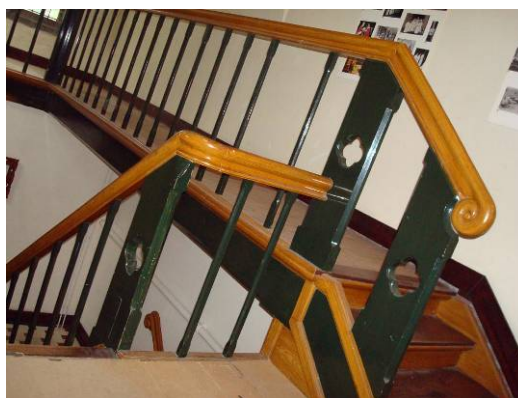
Afb. 79 Het bovenste bordes van de zuidelijke traptoren.
