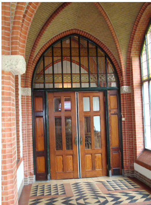
Afb. 150 Dubbele deur met bovenlicht en dichte zijpanelen tussen de gangen van de voorbouw en de noordvleugel (begane grond).
