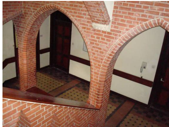
Afb. 66 Detailopname van het trappenhuis in de noordvleugel, gezien naar de gang.
