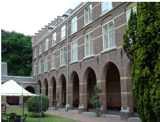
Afb. 23 Arcade van de noordelijke hofgevel.
