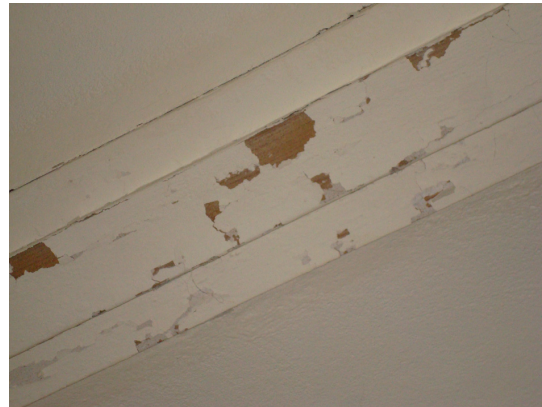
Afb. 132 Detailopname van het gewelf in de westelijke middengang van de noordvleugel. Onder de witsellagen is de oorspronkelijke afwerklaag te voorschijn gekomen.
