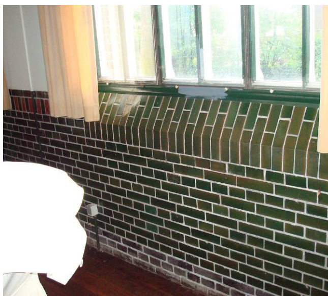
Afb. 102 Detailopname van de lambris met een gemetselde afzaat onder het venster. De plint van grijs geglaazuurde steen is eveneens zichtbaar.
