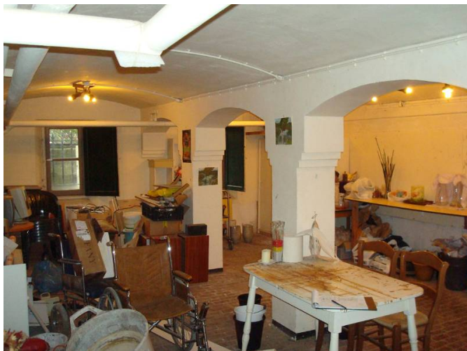
Afb. 121 De vroegere aardappelkelder in de voorbouw heeft drie parallelle ton- of segmentgewelven die rusten op een dubbele rij pijlers.
