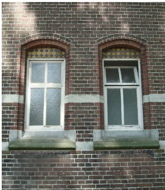
Afb. 36 Profielstenen rondom twee toiletraampjes in de zuidgevel.
