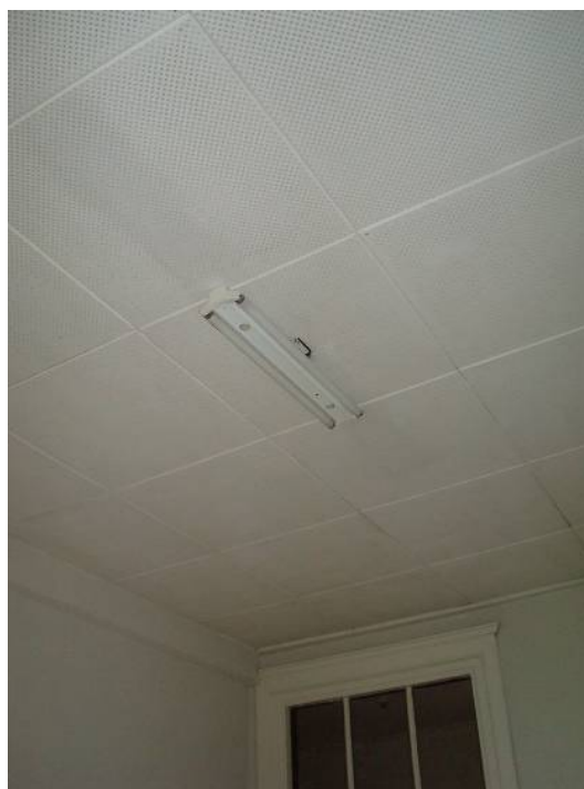
Afb. 136 Plafond met akoestische tegels op de eerste verdieping van de zuidvleugel in een voormalige studentenkamer.
