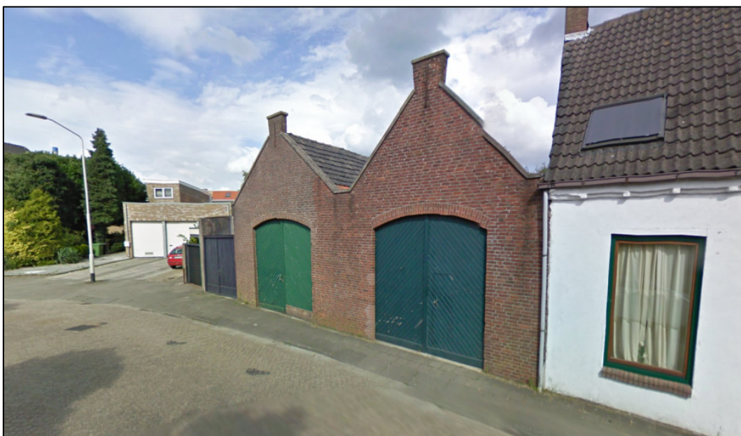
Garages aan het West-Vaardeke 38 Bron: Google streetview, 2015
