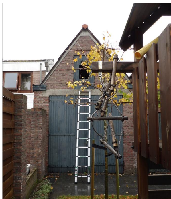
Foto 14: Inspectie van zolderruimte garage B
