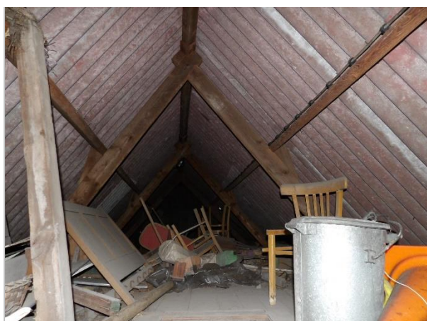
Foto 15: Zolderruimte garage B
