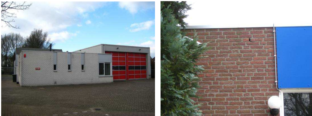
Afbeelding 5.2: De brandweerkazerne en spouwmuurgat in de sporthal.
