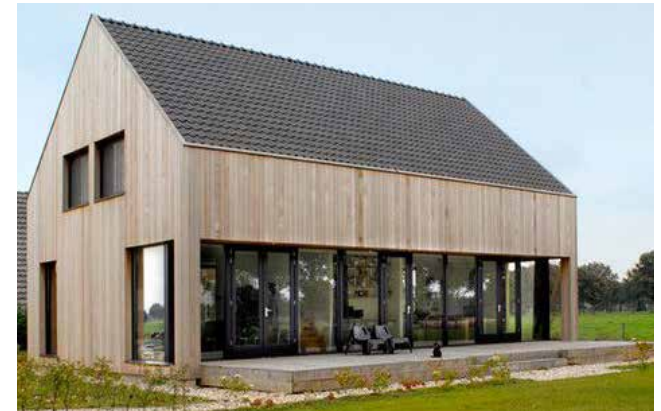
De compositie van de gevels en het dak is sober in opzet en heeft een robuuste uitstraling
