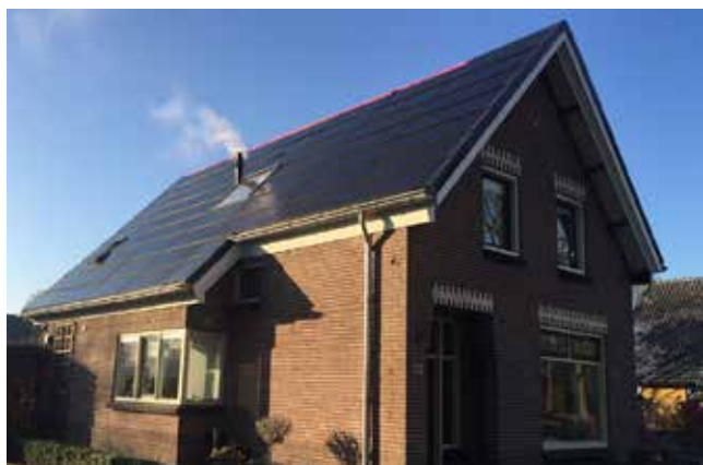
Zonnepanelen bij voorkeur geïntegreerd in het dakvlak
