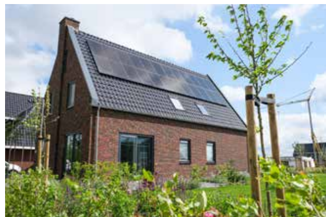
Zonnepanelen in regelmatig patroon en afgestemd op het dakvlak
