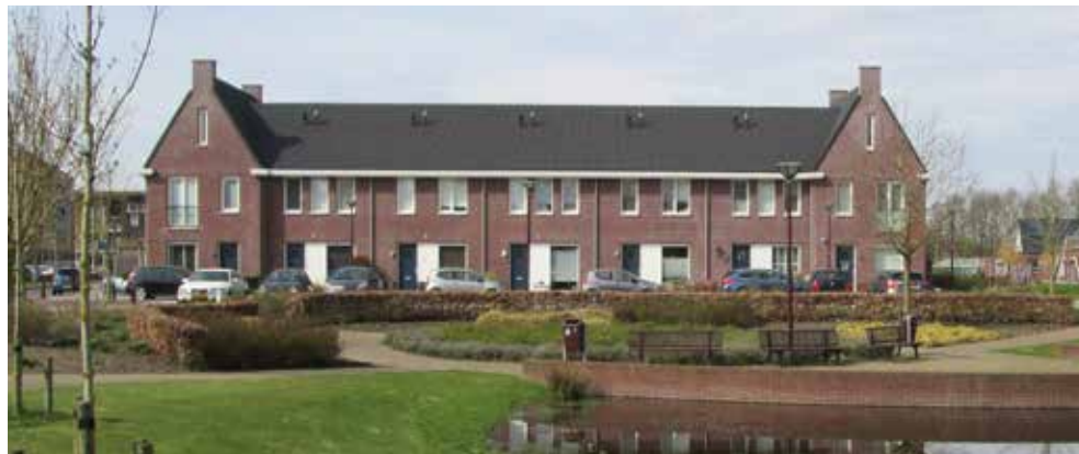
Eigentijds dorpse architectuurstijl met een eenvoudige en heldere hoofdvorm, verbijzondering hoeken en een uitvoering in donker roodbruin metselwerk met antracieten kap
