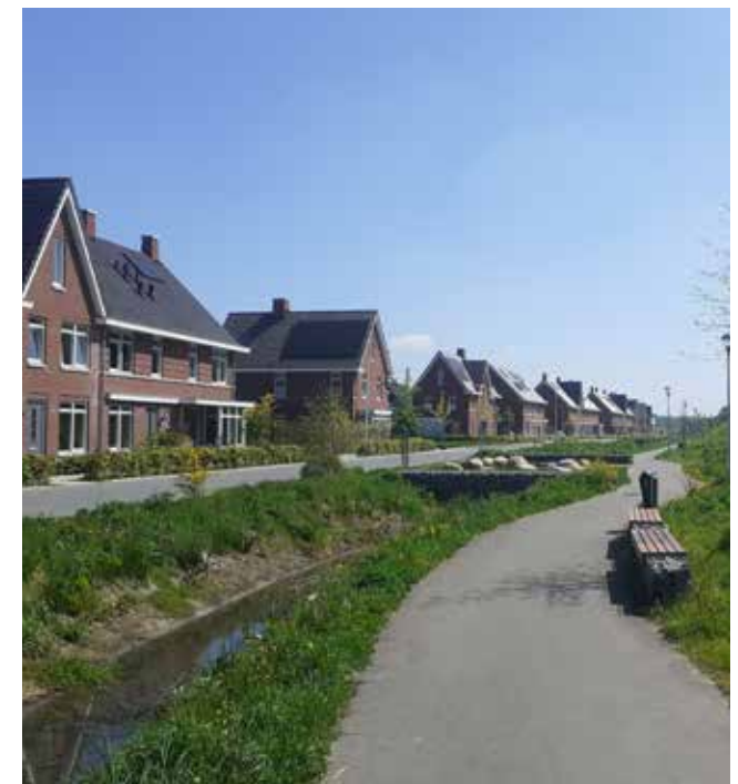
Afwisselend dorps straatbeeld door geleding in de bouwmassa, samenhang door materiaal- en kleurgebruik
