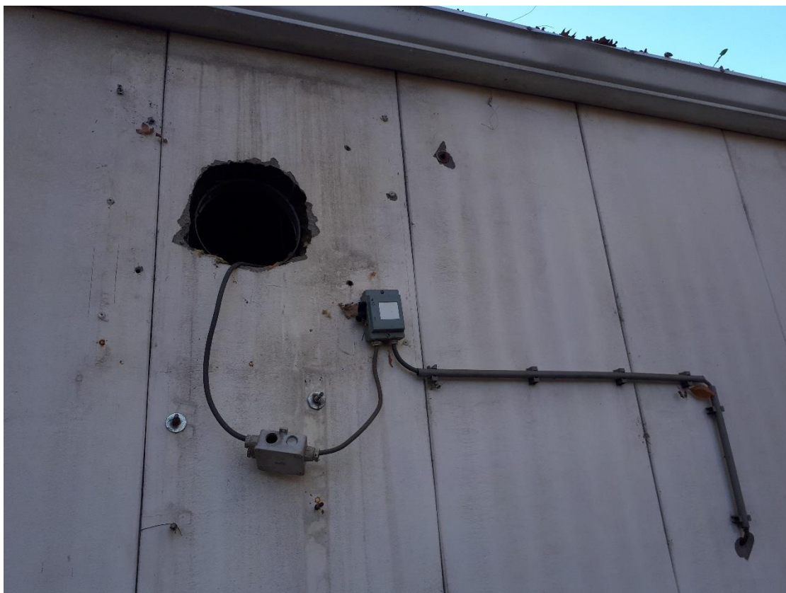
Figuur 12. Door gaten van deze grote kan een steenmarter gemakkelijk binnen komen.
