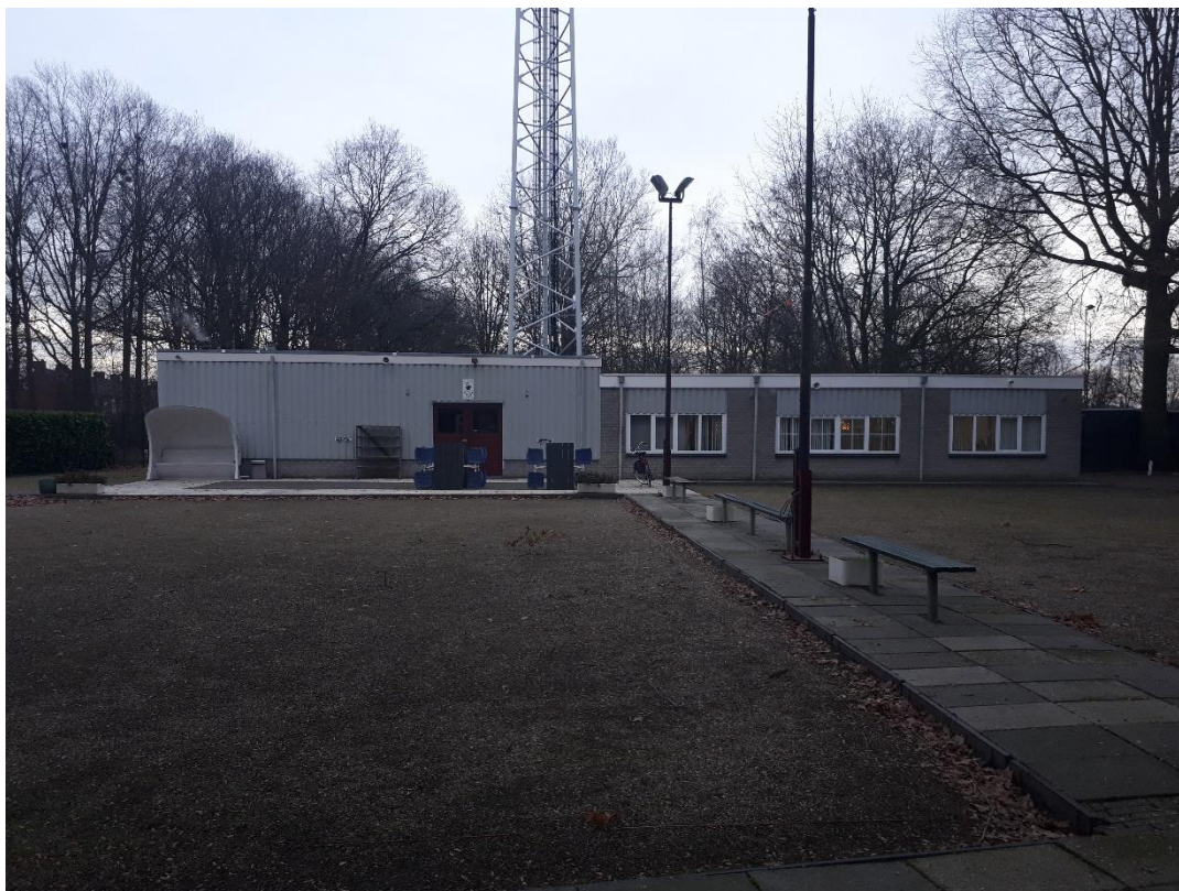
Figuur 7. Het westelijke gebouw met golfplaten gevels, daklijsten en een spouwmuur.
