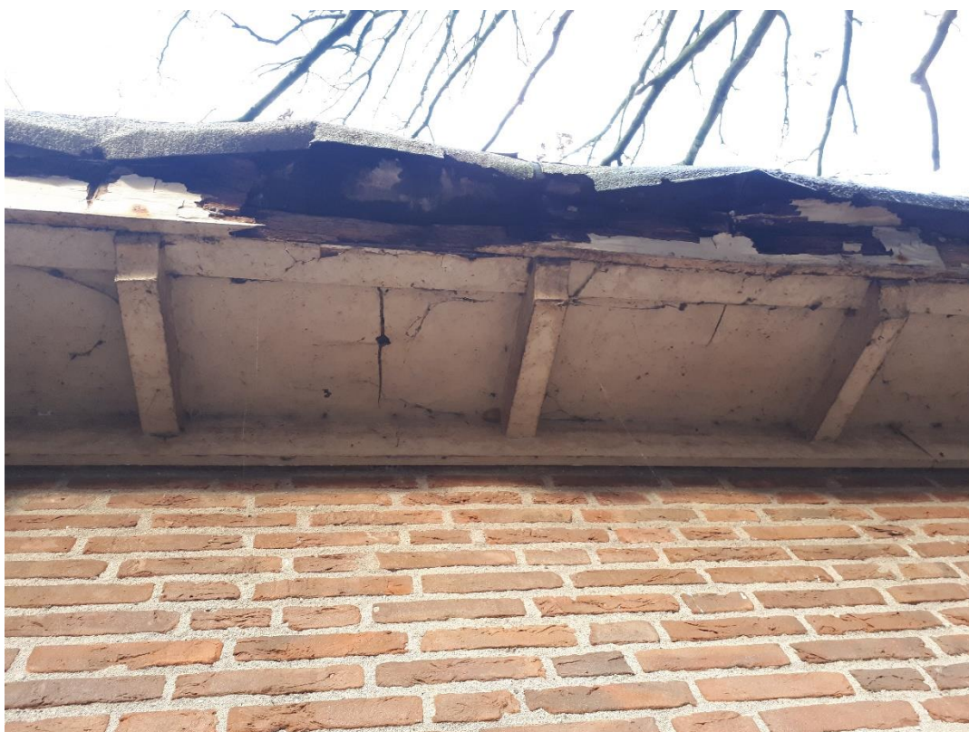
Figuur 10. Door gaten in de betimmering kan door marters of vleermuizen de ruimte onder het dak worden bereikt.
