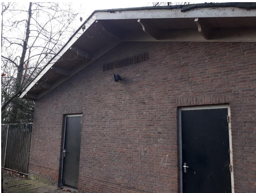
Figuur 9. Het middelste gebouw met houten betimmering, spouwmuren en bitumen dakbedekking. Door de open stootvoegen kan door vleermuizen de spouw worden bereikt.
