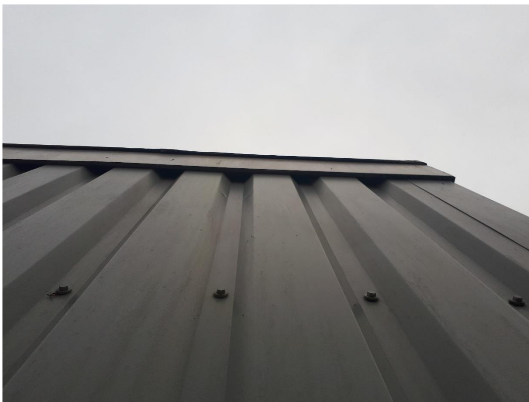
Figuur 8. De daklijsten bieden voldoende ruimte voor vleermuizen om achter te kruipen en zo de spouw te bereiken.
