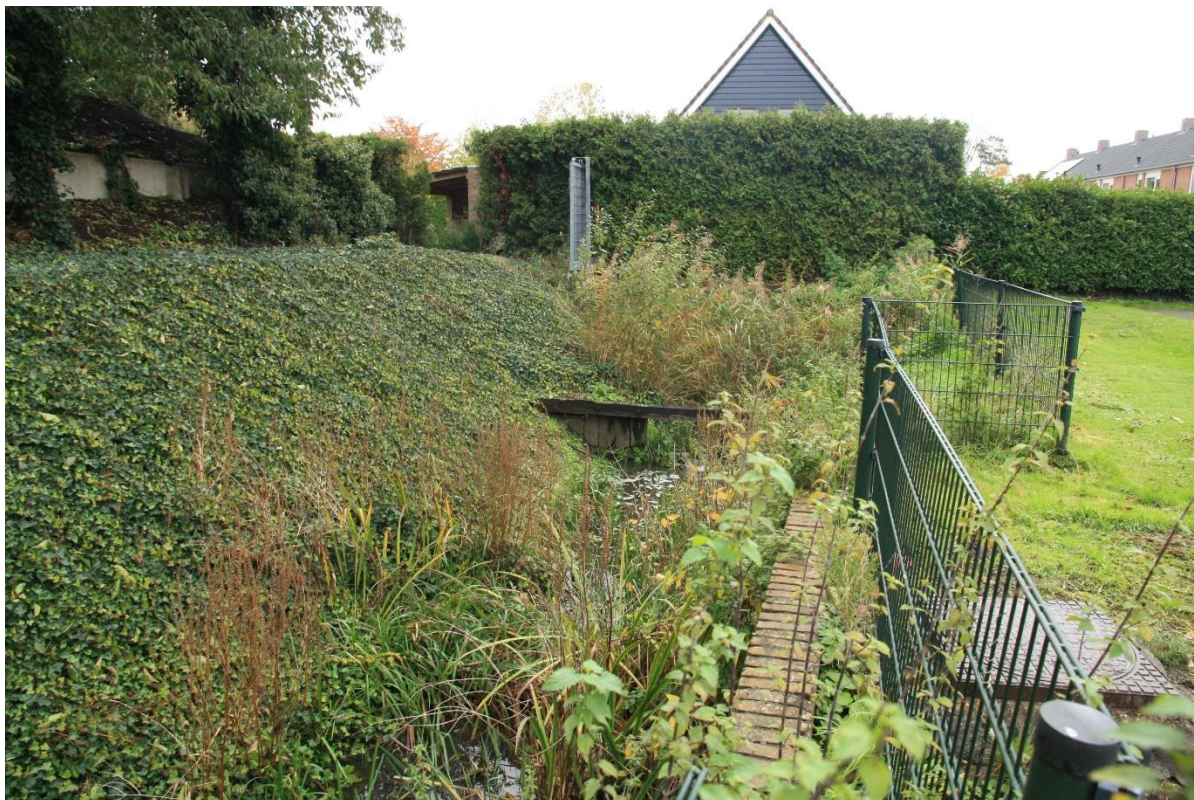
Figuur 3-6: Afvoersloot die gevoed wordt door water van de waterberging nabij de Wolfsstraat. Dit deel wordt overkluisd.
