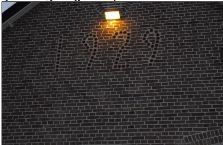
Figuur 2: Foto topgevel langgevelboerderij metselwerk.
