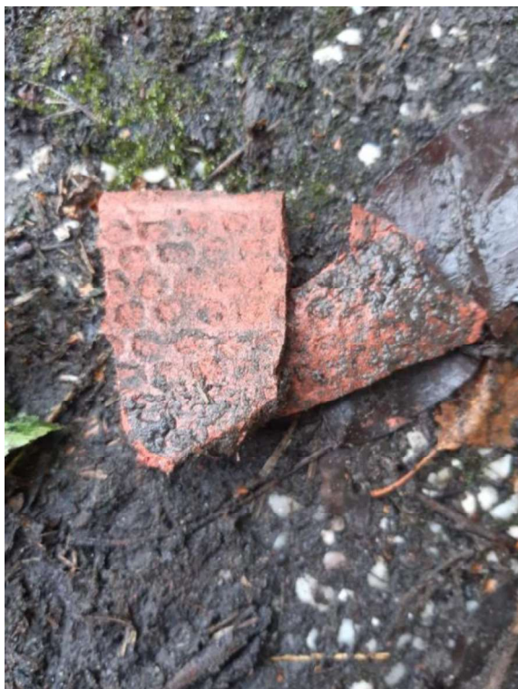
Foto 3: Asbestverdacht plaatmateriaal afkomstig van asbest inspectiegat 110 / G8
