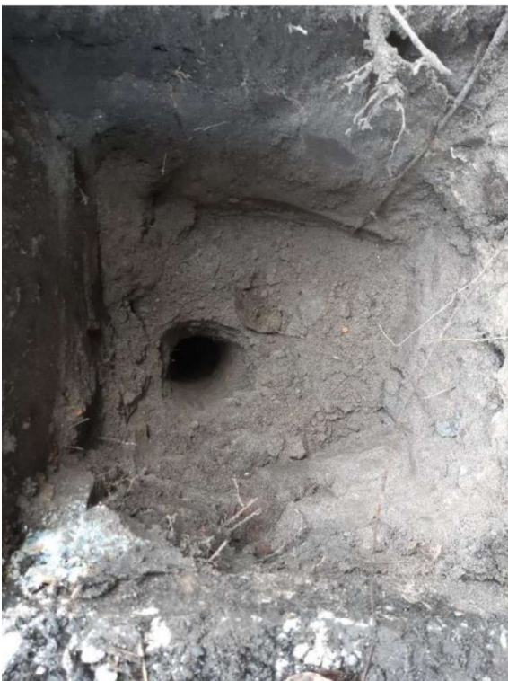
Foto 2: Asbest inspectiegat 110 / G8
