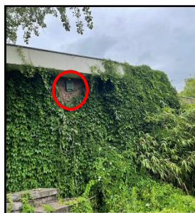
Figuur 11. Tijdelijke kast noordwesthoek onderzoekslocatie.
