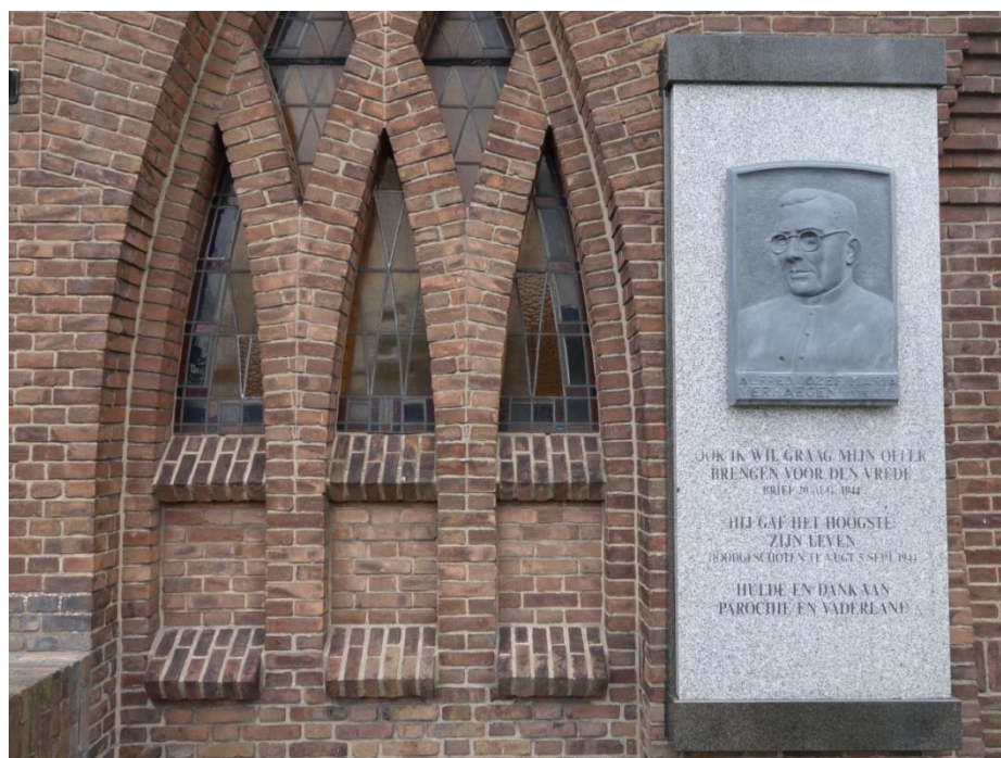
Afbeelding 21: de plaquette ter gedachtenis van kapelaan A. Verhagen. Daarbij een goed beeld van de opbouw van een vensters in de entree.
