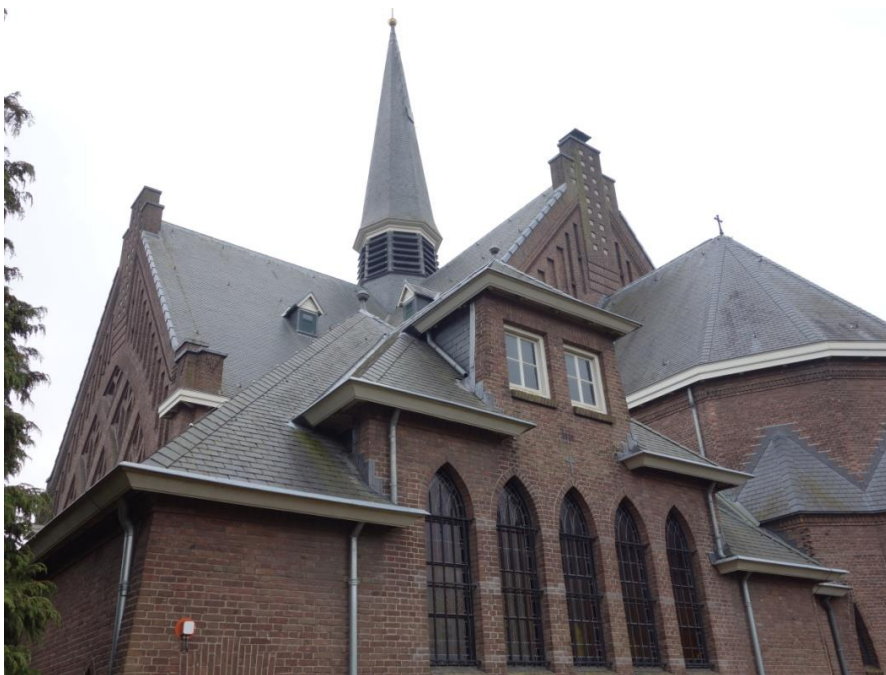
Afbeelding 18: het tentdak met dakhuis van de sacristie. Tevens zijn de twee dakkapellen in de dakvlakken van de kerk en de spitse vieringtoren te zien.
