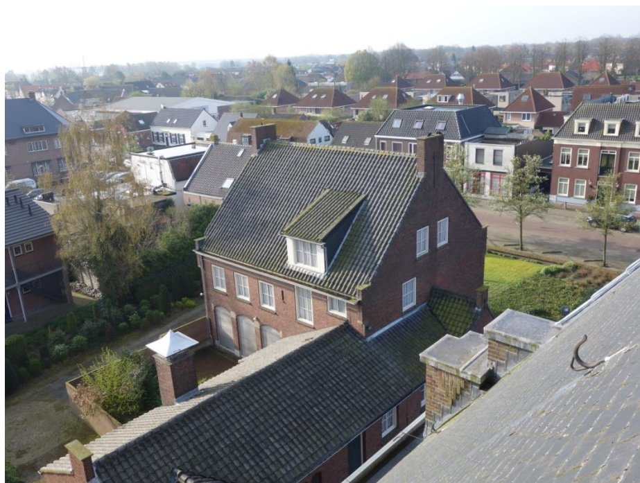
Afbeelding 19: de daken van de pastorie gezien vanuit een dakkapel van de kerk.
