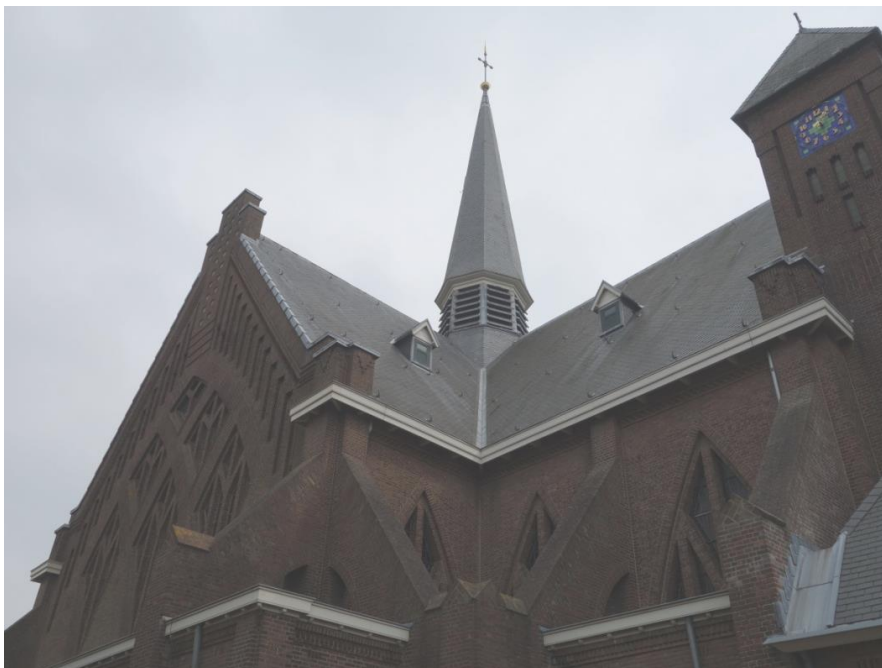
Afbeelding 22: de linkerzijgevel van de kerk. Aan de onderzijde de boei langs de omgang en het platte dak daar op, daarboven de vensters in de traveeën en dwarsbeuk.
