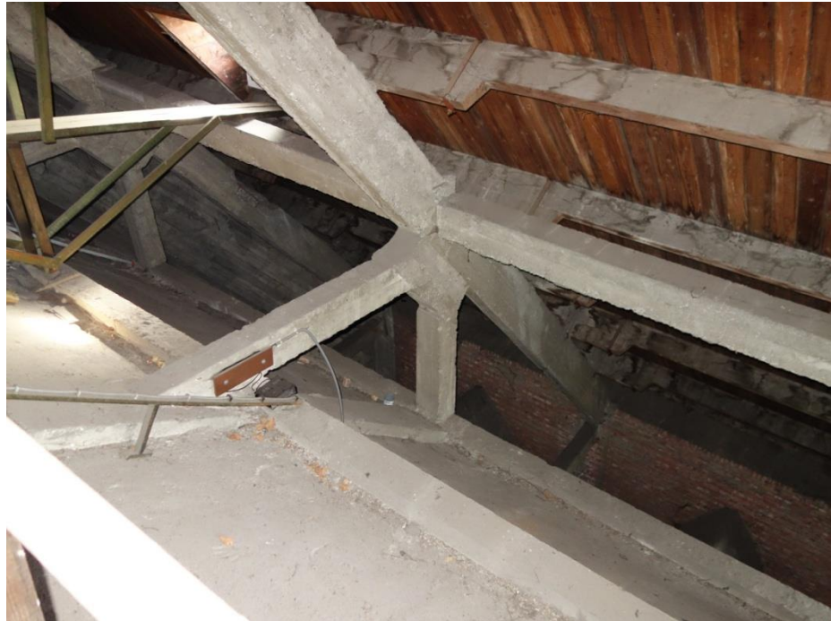
Afbeelding 16: de afdracht van de betonnen spantconstructie op het gewelf en de muur. Op het spant liggen houten gordingen.
