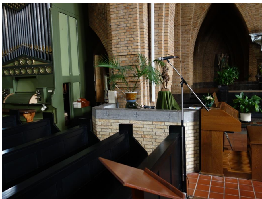
Afbeelding 33: De later opgetrokken voet van de preekstoel. Het metselwerk doorbreekt het patroon van de (hier reeds vervangen) tegelvloer.
