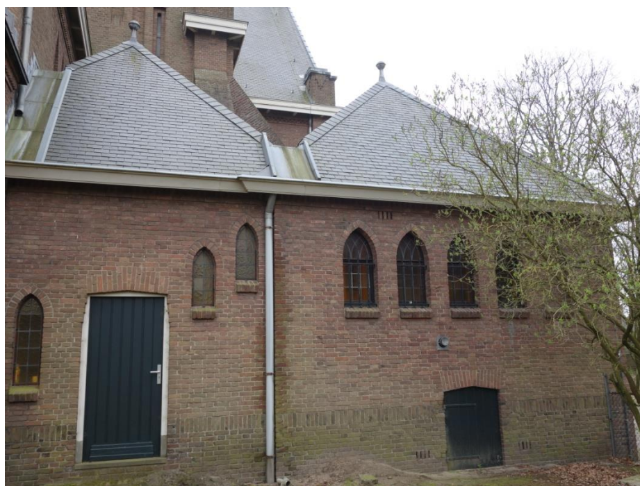
Afbeelding 24: de ruimtes ter linkerzijde van het koor met links de buitendeur met achterliggende verkeersruimte en toilet.
