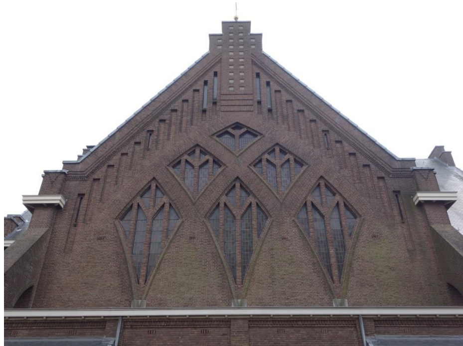
Afbeelding 13: de buitengevel van het linker dwarsschip. De zes spitsboogvormige vensters zijn van binnenuit zichtbaar. In de klimmende fries zijn vier smalle vensters geplaatst die licht onder kap toe laten.
