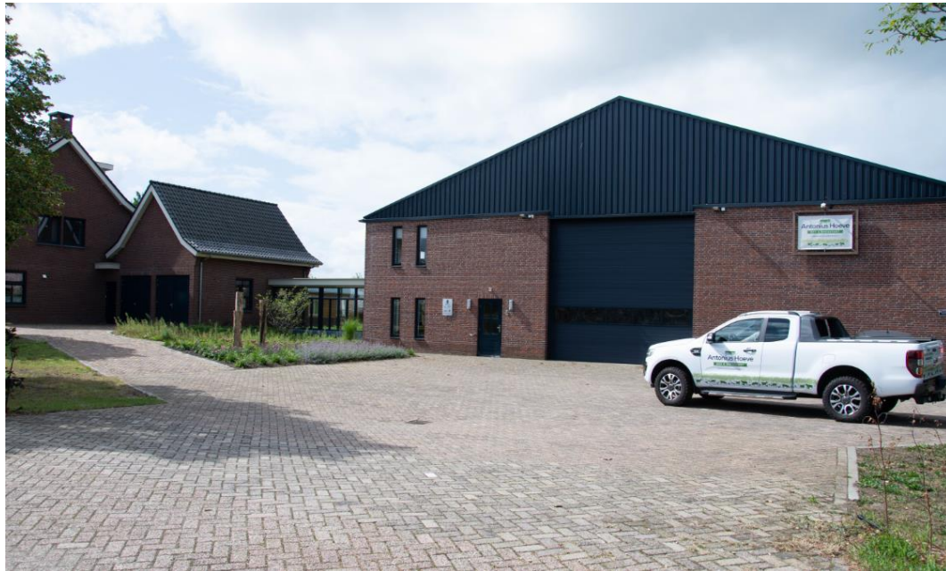
Figuur 2.2: foto bijgebouw/loods op het perceel Nattestraat 8
