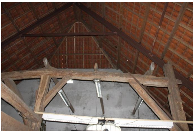
Oorspronkelijke gebint met daarboven de staalconstructie
