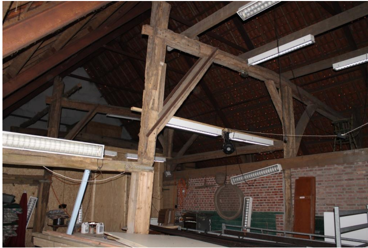
Afgezaagde ankerbalkgebinten
