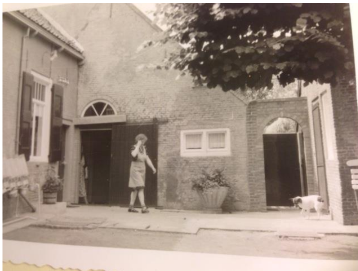
Rechterzijgevel bedrijfsgedeelte in jaren '60/'70 20 ste eeuw. Bron: dhr. Van Domburg
