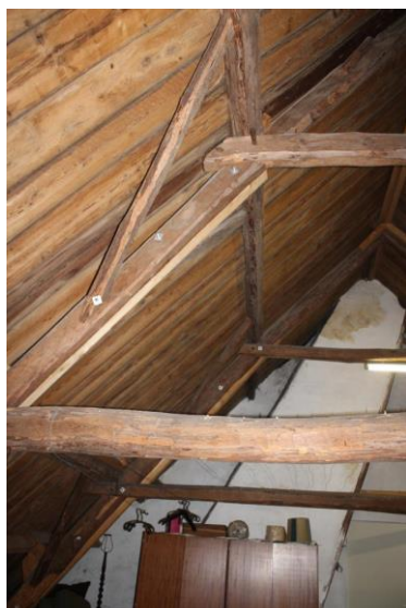
19 e eeuwse spantbenen verstevigd
