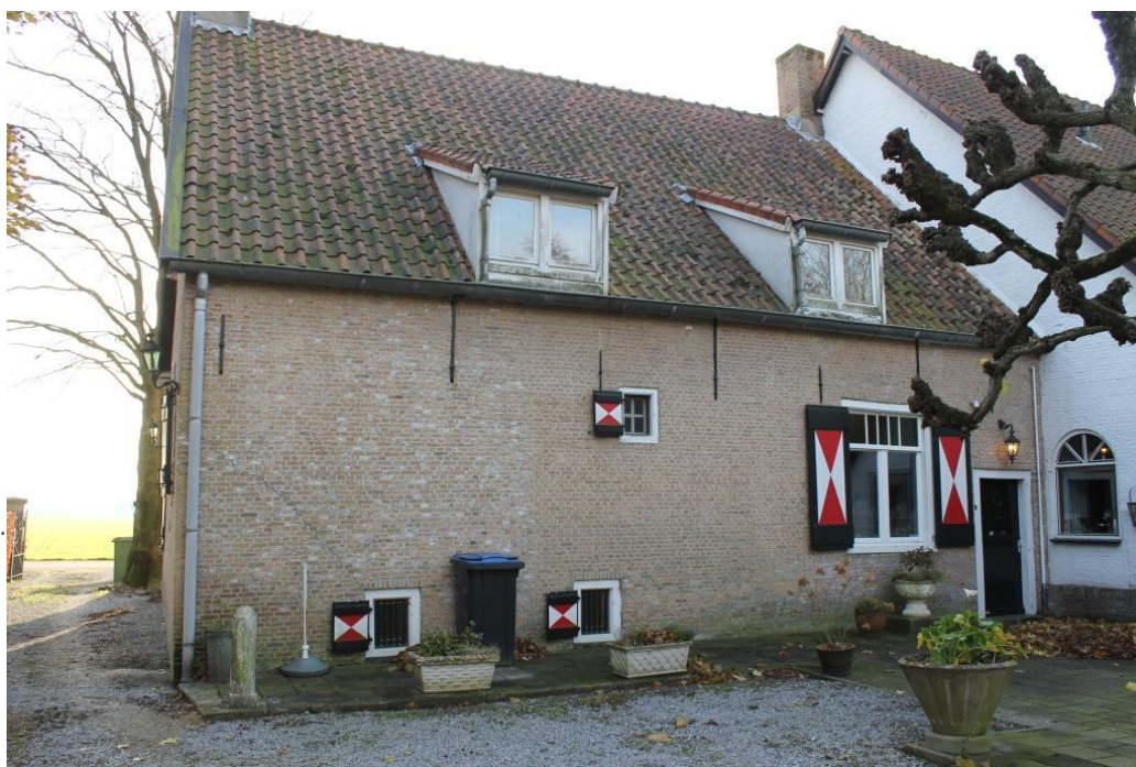
Achtergevel woonhuis met links een wijziging in het metselwerk
