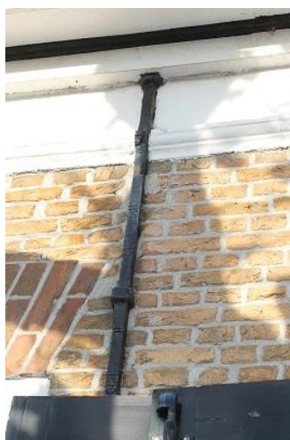
Muuranker 19 e eeus spant
