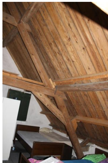
Latere aangebracht spant van machinaal gezaagd hout
