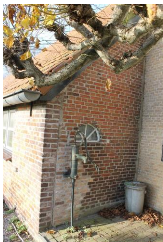
Huidige rechterzijgevel aan voorzijde van de woning
