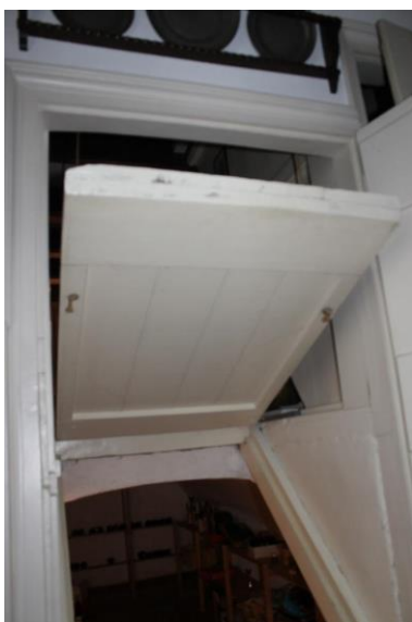
Toegang kelder onder trapopgang opkamer
