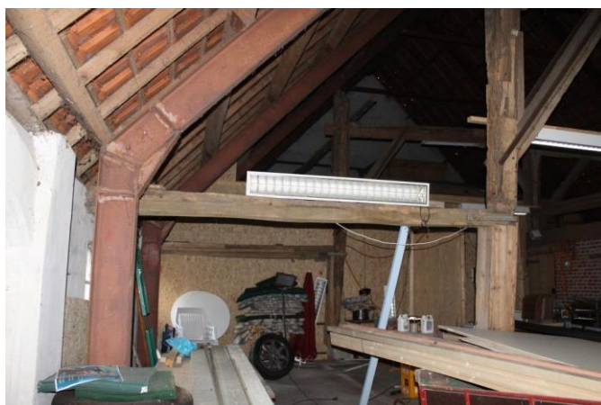
Staalconstructie met oorspronkelijke koppelbalk
