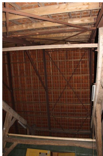
Stalen spanten met windverband waarop tengels en panlatten
