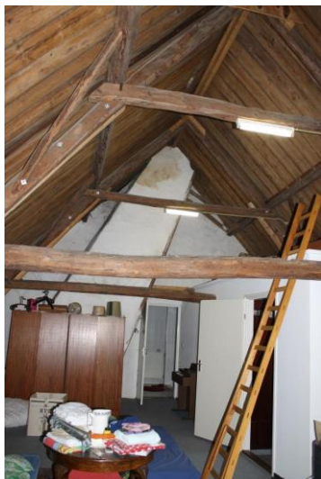
Oorspronkelijke 19 e eeuwse spanten
