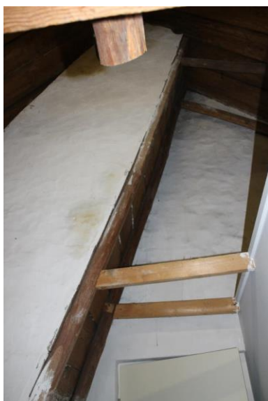
Schouw en brandmuur
