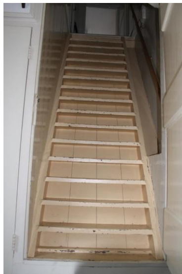
Houten trap naar verdieping
