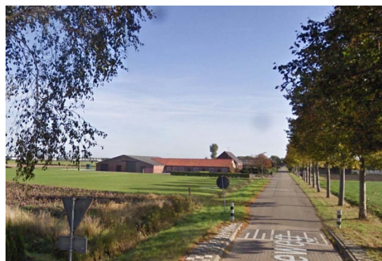
De foto toont het perceel met opstallen vanuit het Westen.
