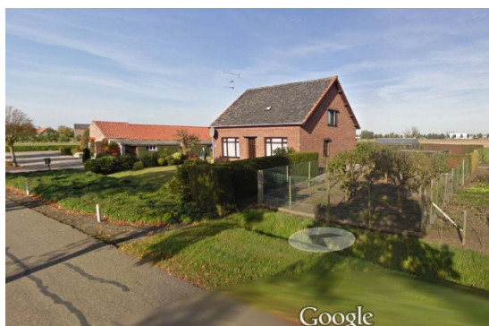
De foto toont het woonhuis vanuit het Oosten.
