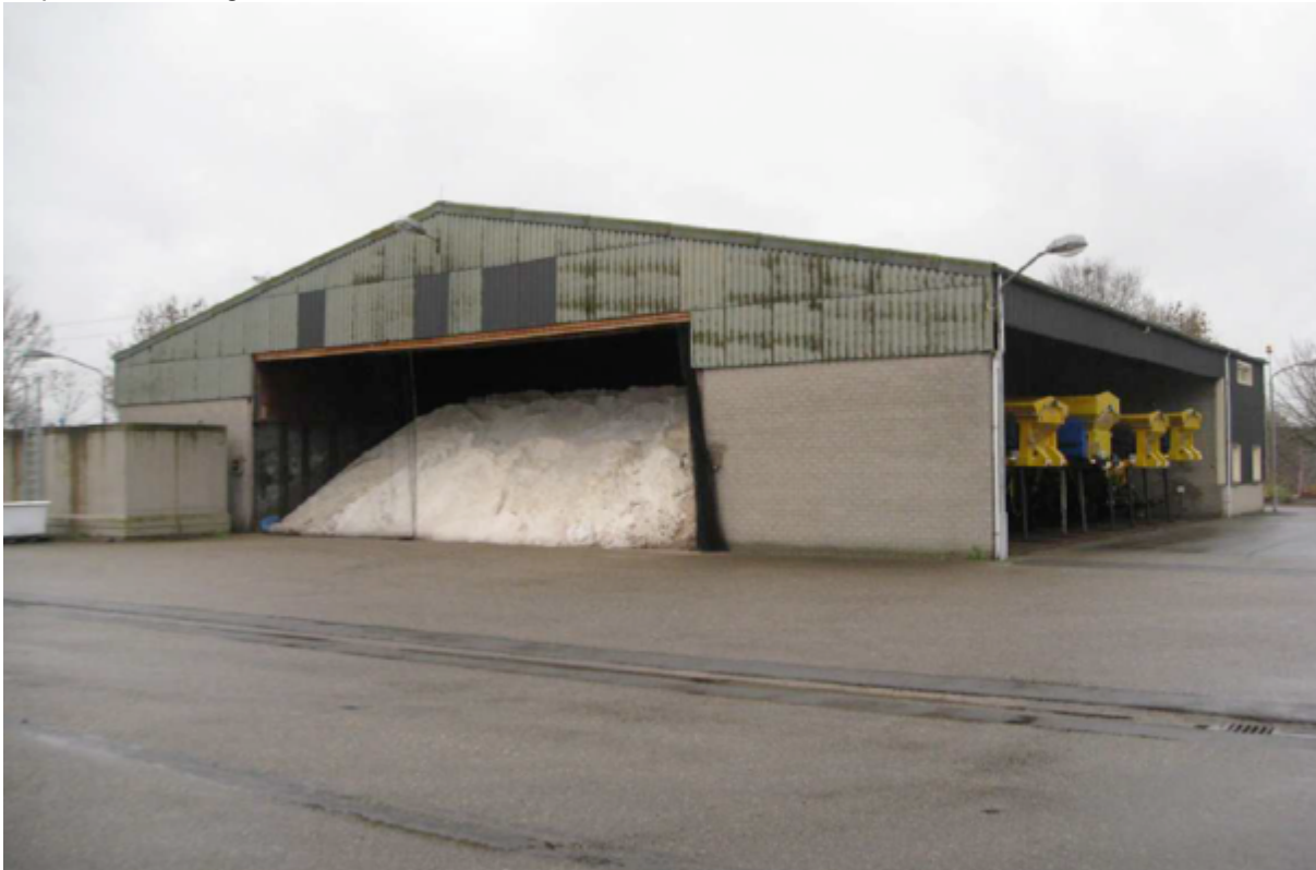
Foto van de bestaande zoutloods (bron Asbo; adviseurs bouw en onderhoud)
