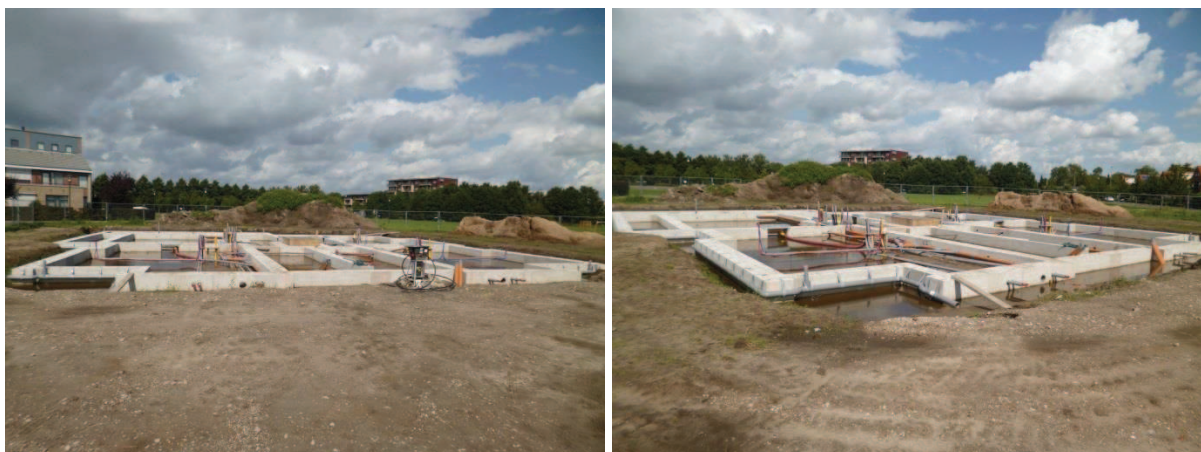
Figuur 7: Bestaande situatie, na aanvang bouw
