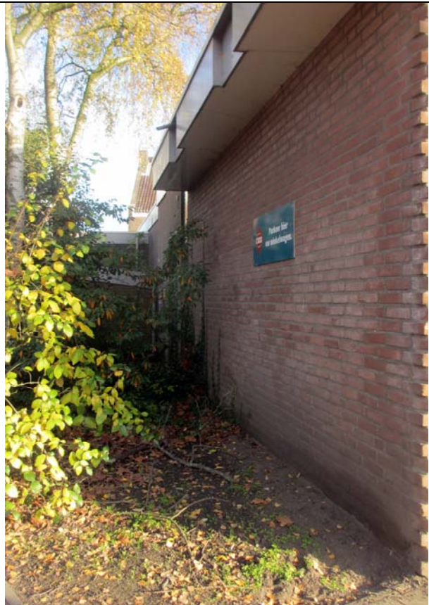
Fig. 7. Detail van deel van het pand wat gesloopt wordt.
