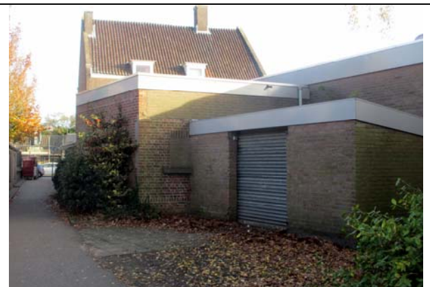
Fig. 4. Te slopen achterzijde winkelpand.
