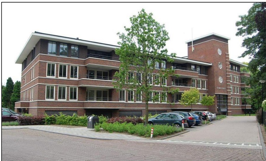
Aanzicht van de ten westen van het plangebied gelegen gestapelde woningen. Op de voorgrond is de hoek in de Lollestraat zichtbaar.
