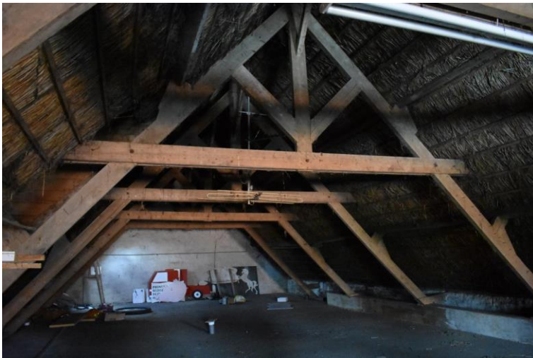
Verbeterd Hollands spant boven het bedrijfsgedeelte.
