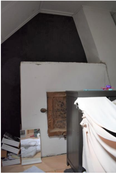
Rookkanaal tegen brandmuur.
