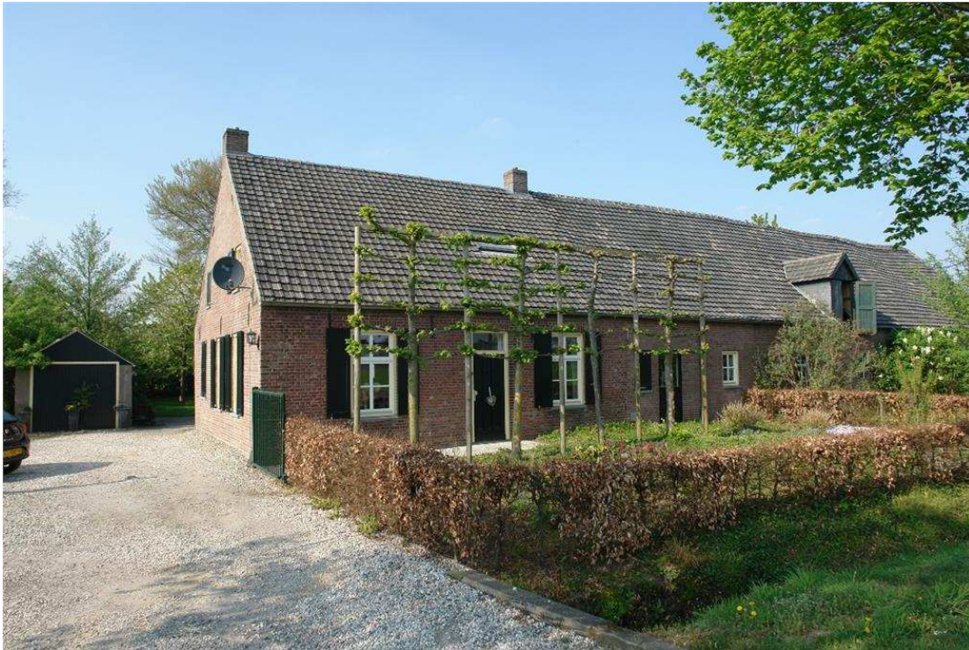
Figuur 4: Voorgevel en kopgevel woonboerderij Wolfskamp 3
