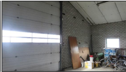
Foto 2. Binnenkant van de loods aan de westzijde
