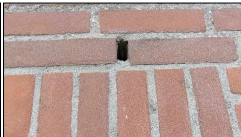
Foto 6. Een van de stootvoegen
