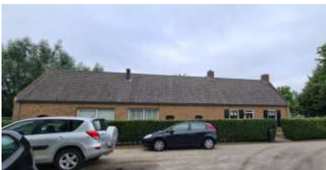
Figuur 7: Woonboerderij in het zuiden van het plangebied
