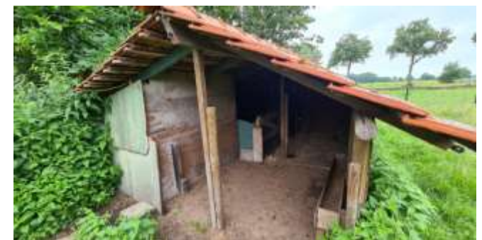
Figuur 6: Openingen in de muren van opstal in het zuidwesten van het plangebied
