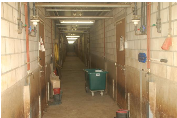
Afbeelding: binnenzijde varkensstallen
