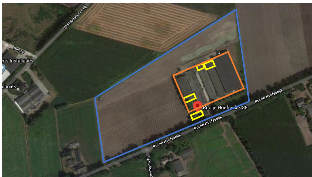
Afbeelding: met globaal omljnd de totale planlocatie in blauw, te slopen bedrijfsgebouwen in oranje en blijvende bedrijfswoning met bijbouw en loods in geel. Bron: google maps.
