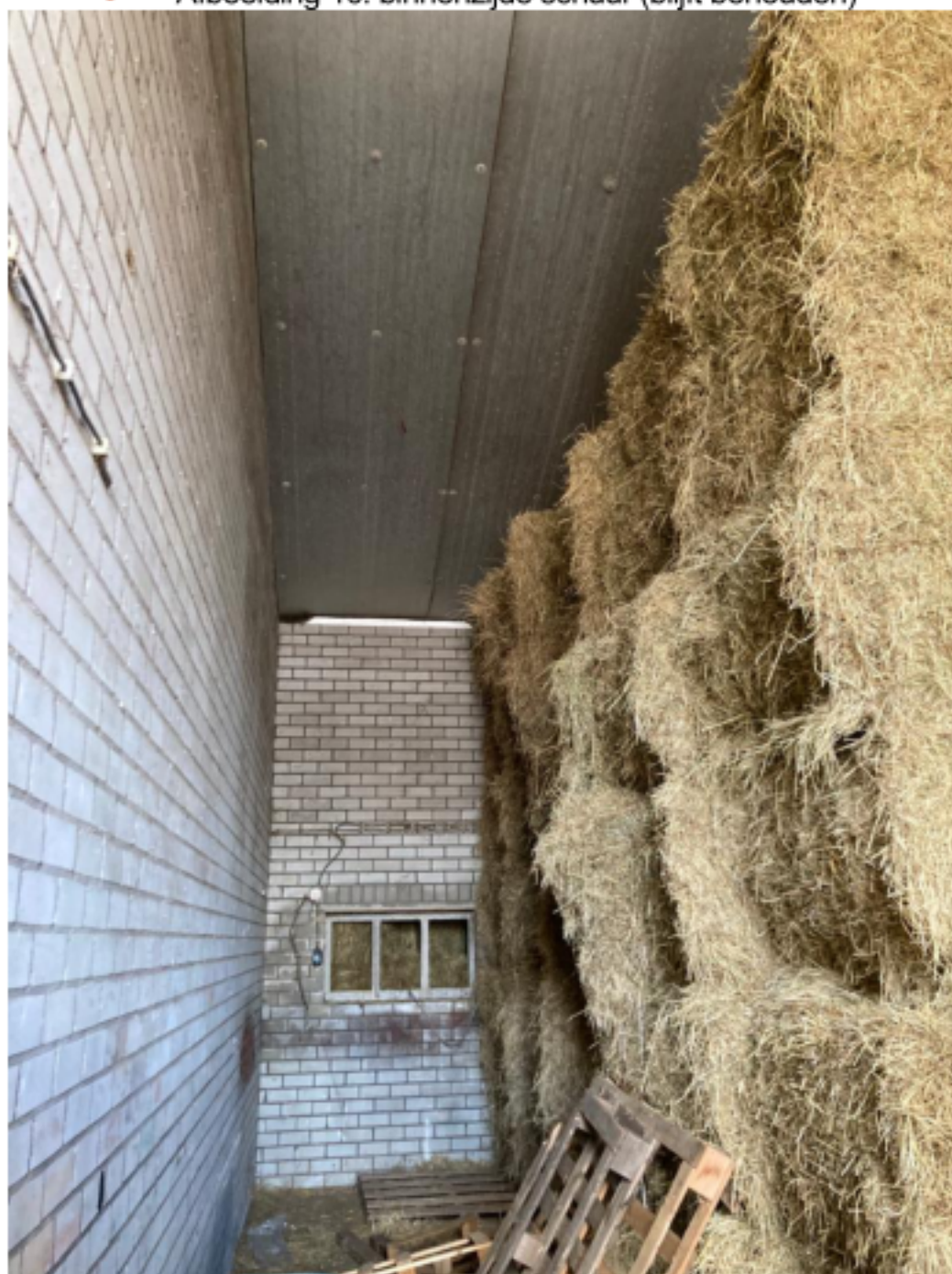
• Afbeelding 10: binnenzijde schuur (blijft behouden)
