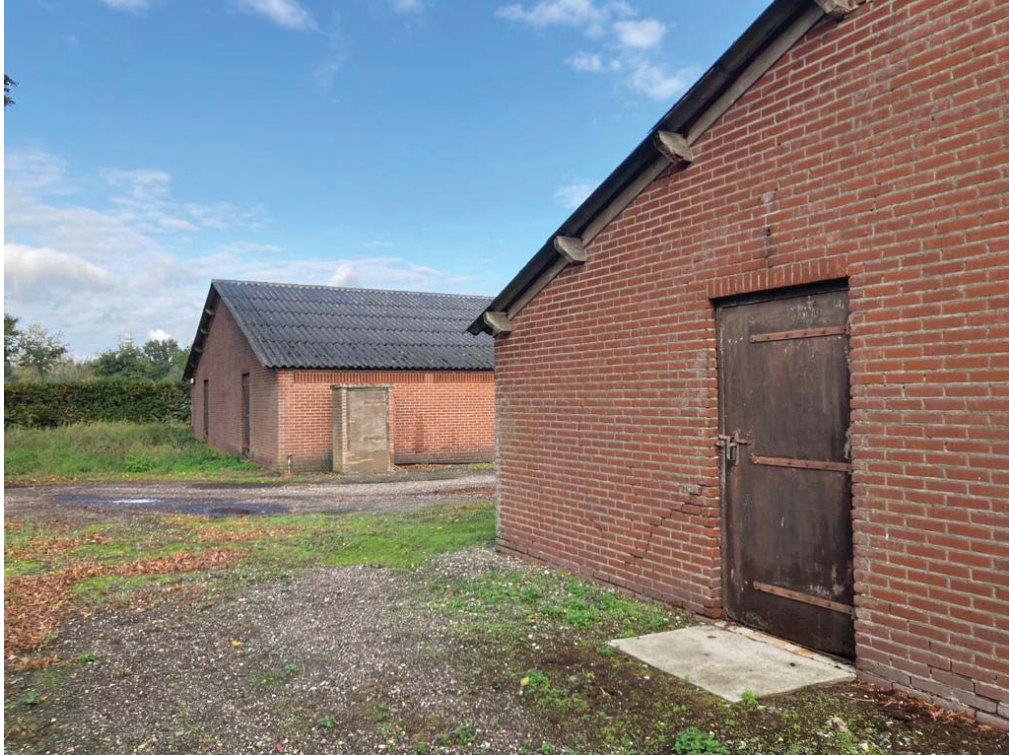
• Afbeelding 13: te slopen varkensstallen
