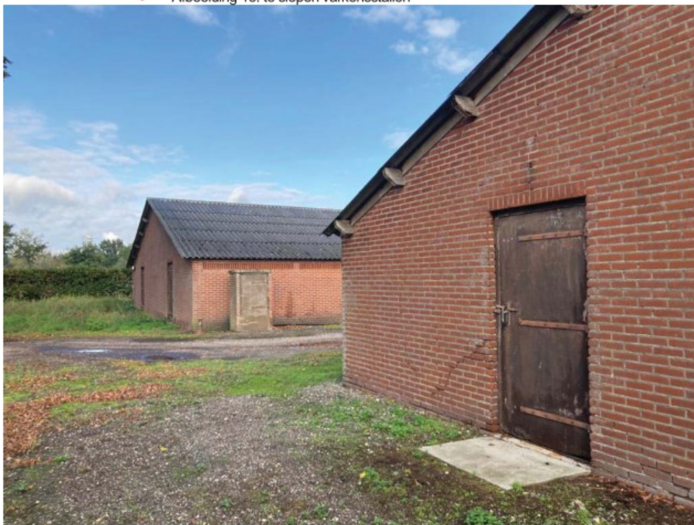
• Afbeelding 13: te slopen varkensstallen
