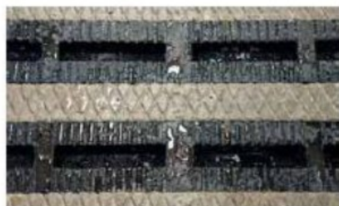
Bijlage 1: Foto's en detailtekeningen roostervloer voorzien van afdichtingcassettes in de roosterspleten
