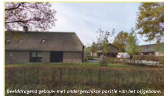
Bedrijfsbebouwing: sobere en doelmatige vormgeving en uitstraling.
