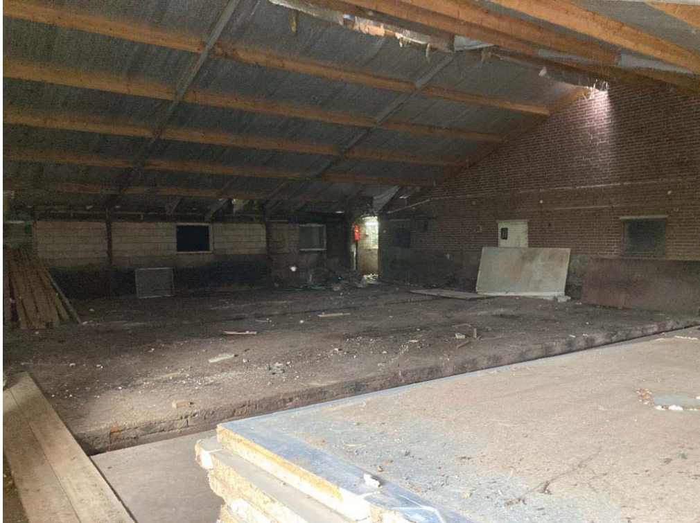
• Afbeelding 13: binnenzijde te slopen gebouw
