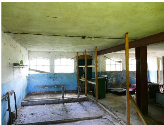
Interieur van de stal met een zolder van beton en een ijzeren draagconstructie
