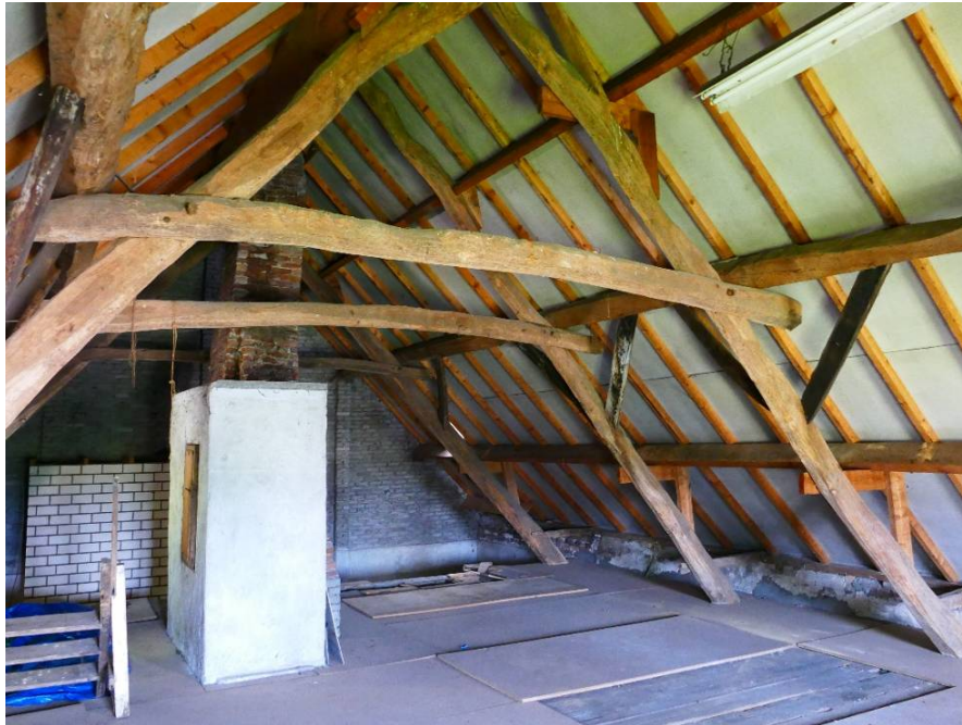
Kapconstructie boven het woongedeelte
