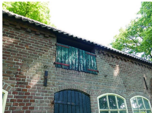
Het hooiluik op de plaats van de getoogde mestdeuren van de stal
