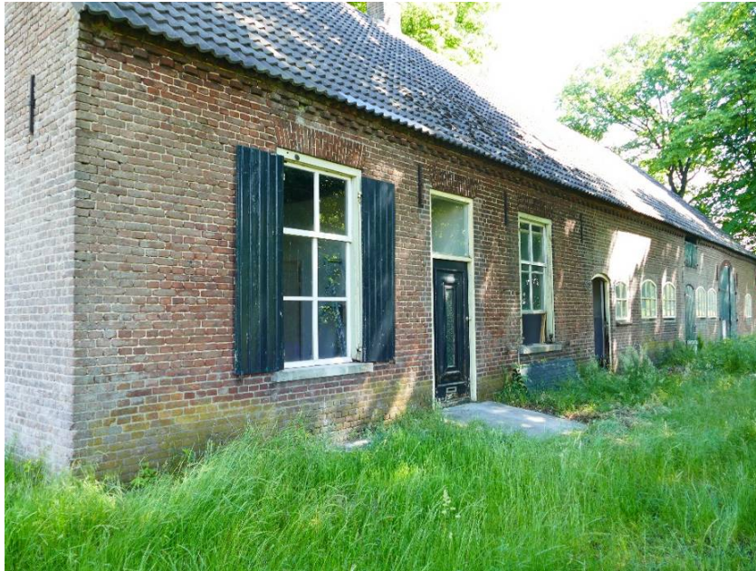
Voorgevel van de boerderij met symmetrische positionering van voordeur en vensters. Voorheen had ook het bedrijfsgedeelte twee stellen hoge deuren in een symmetrische positie.
