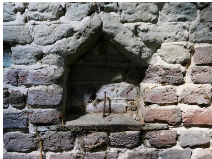
Nis in scheidingsmuur van stal en schuur. Deze binnenmuur is met afvalstenen en zonnepakstenen opgebouwd.
