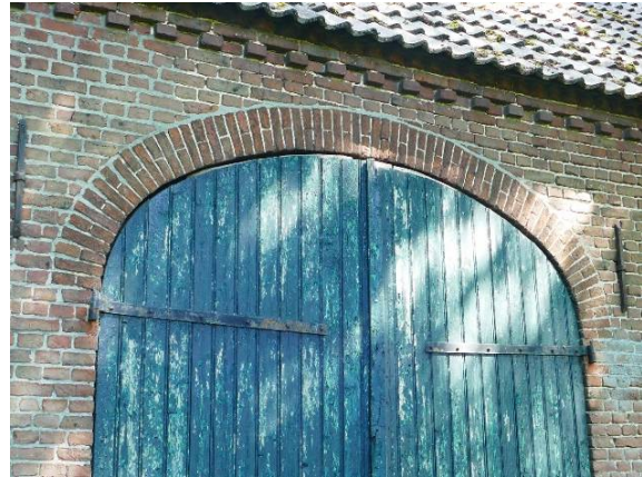
In de schuur zijn de deeldeuren gebleven
