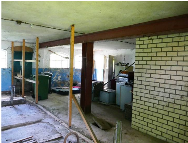
De stalen draagconstructie van de betonnen zolder van de stal. Rechts de later op de voorstal aangebrachte sanitaire ruimten.
