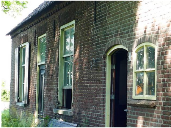
Vensters met hardstenen lekdorpel. De getoogde staldeur rechts is in de plaats gekomen van een deur met bovenlicht,
