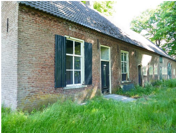
Voorgevel met woongedeelte, stalgedeelte en schuur.
