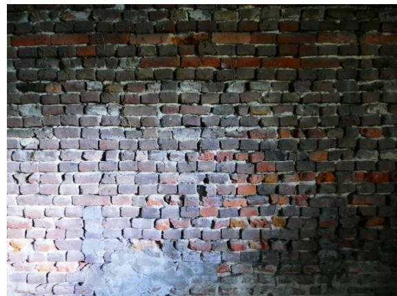
De binnenzijde van de eindgevel heeft als vulling kopse afvalstenen.
