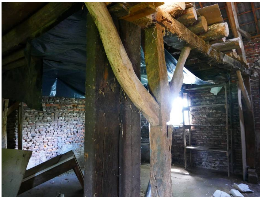
De standvink in het schuurgedeelte bestaat uit hergebruikt eikenhout. Waarschijnlijk afkomstig van het gebint van het voormalige hallenhuis.
