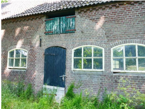
Het bouwspoor van de voormalige mestdeuren in de gevel van de stal.
