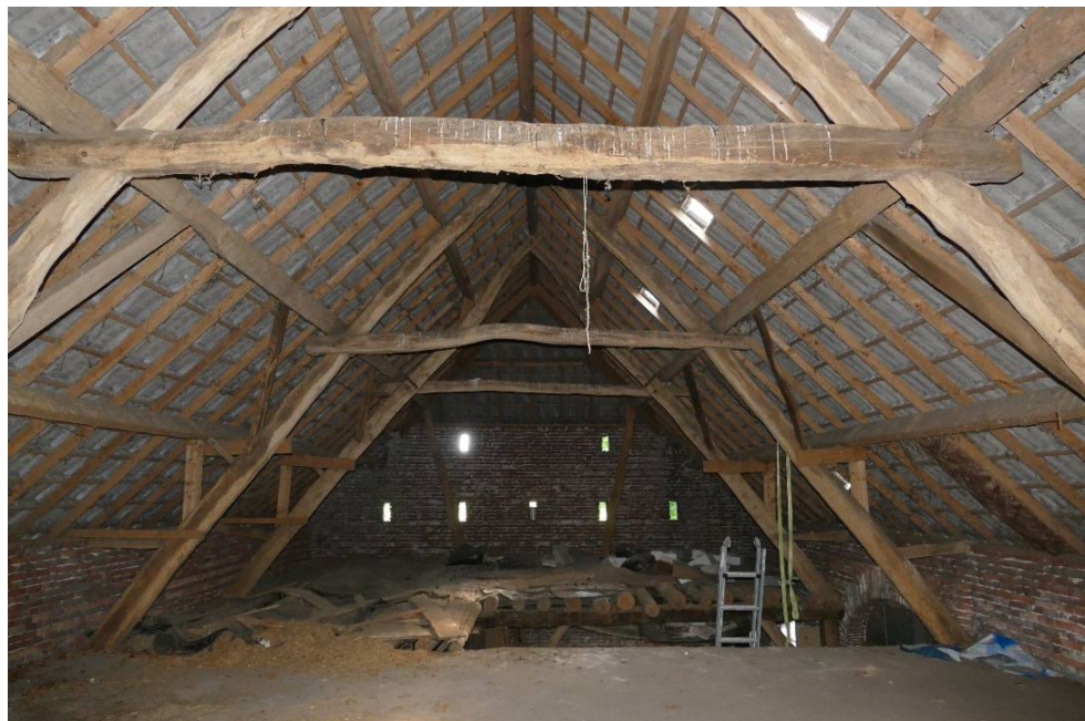
Kapconstructie boven het bedrijfsgedeelte
