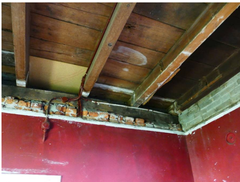
Originele balkenplafond in een van de kamers na verwijdering van het boardplafond.
