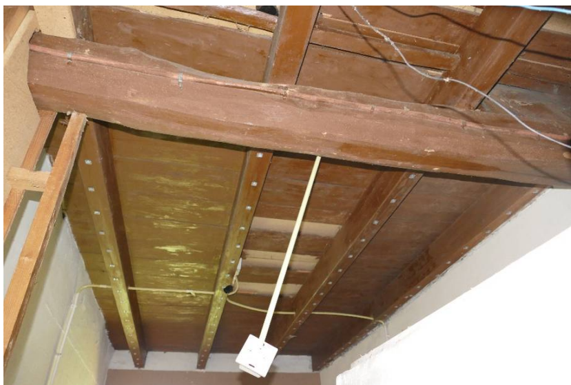
Balkenplafond met robuuste trekbalk.
