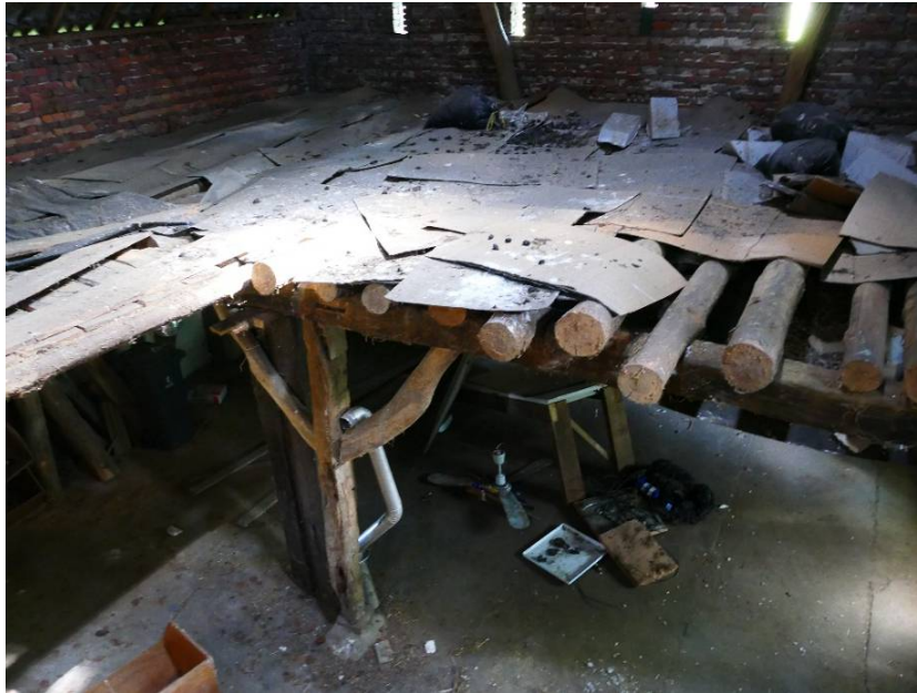
Slietenzolder in schuur. In het midden links een eiken standvink.
